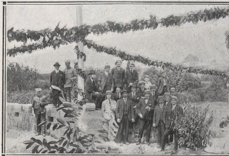
OVIEDO: Los periodistas visitando el lugar donde se construirá la Colonia de la Prensa
