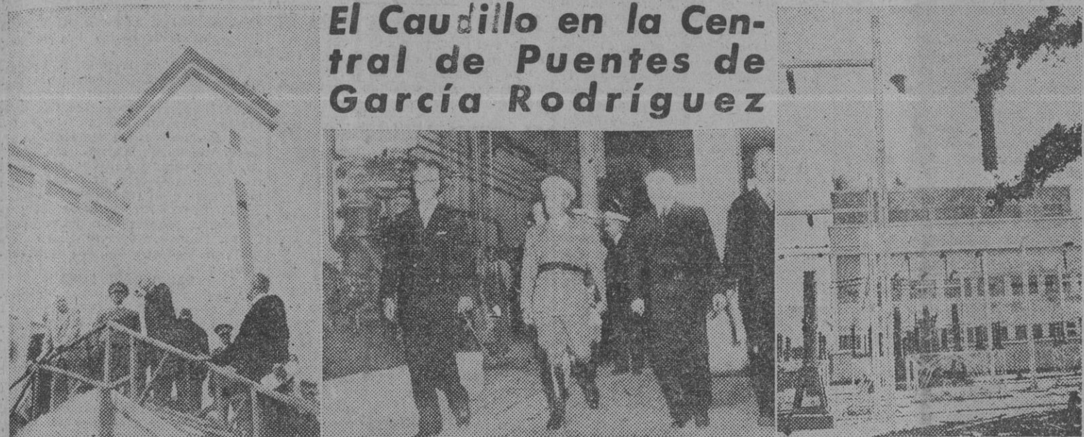
1. El jefe del Estado, acompañado de varios ministros y otras personalidades, contempla las instalaciones de la central. — 2. S. E. recorre las instalaciones. — 3. Vista parcial del edificio y las instalaciones de la central térmica de Puentes de García Rodríguez, inaugurada recientemente por el Caudillo. — (Fotos Cifra)
