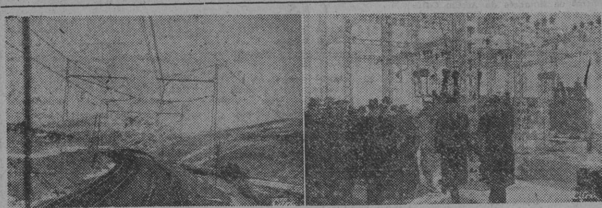
El Excmo. señor ministro de Obras Públicas, ha inaugurado solemnemente el último tramo de la electrificación de la línea férrea Madrid-Avila. Nuestra información recoge una perspectiva del tendido y las personalidades que asistieron al acto inaugural.
