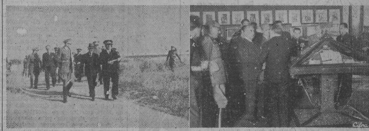
S. E. el Jefe del Estado, Generalísimo Franco, visita las obras del valle inferior del Guadalquivir, en las que destaca la construcción del canal del arroyo de San Juan, obra de ingeniería de colosales proporciones. II. — El Generalísimo en la visita a la interesante exposición del Libro del Caballo. (Fotos Cifra)
