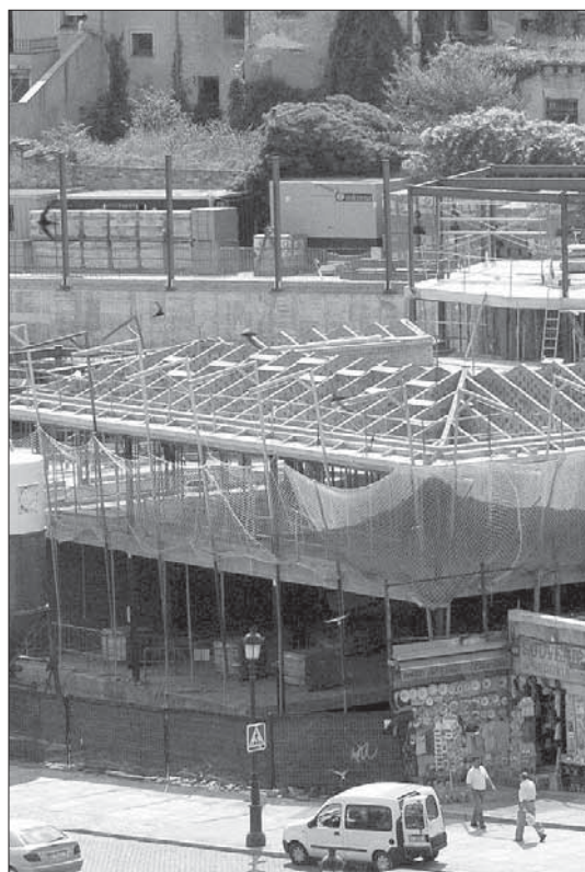
Los trabajos se centran en la construcción del tejado
