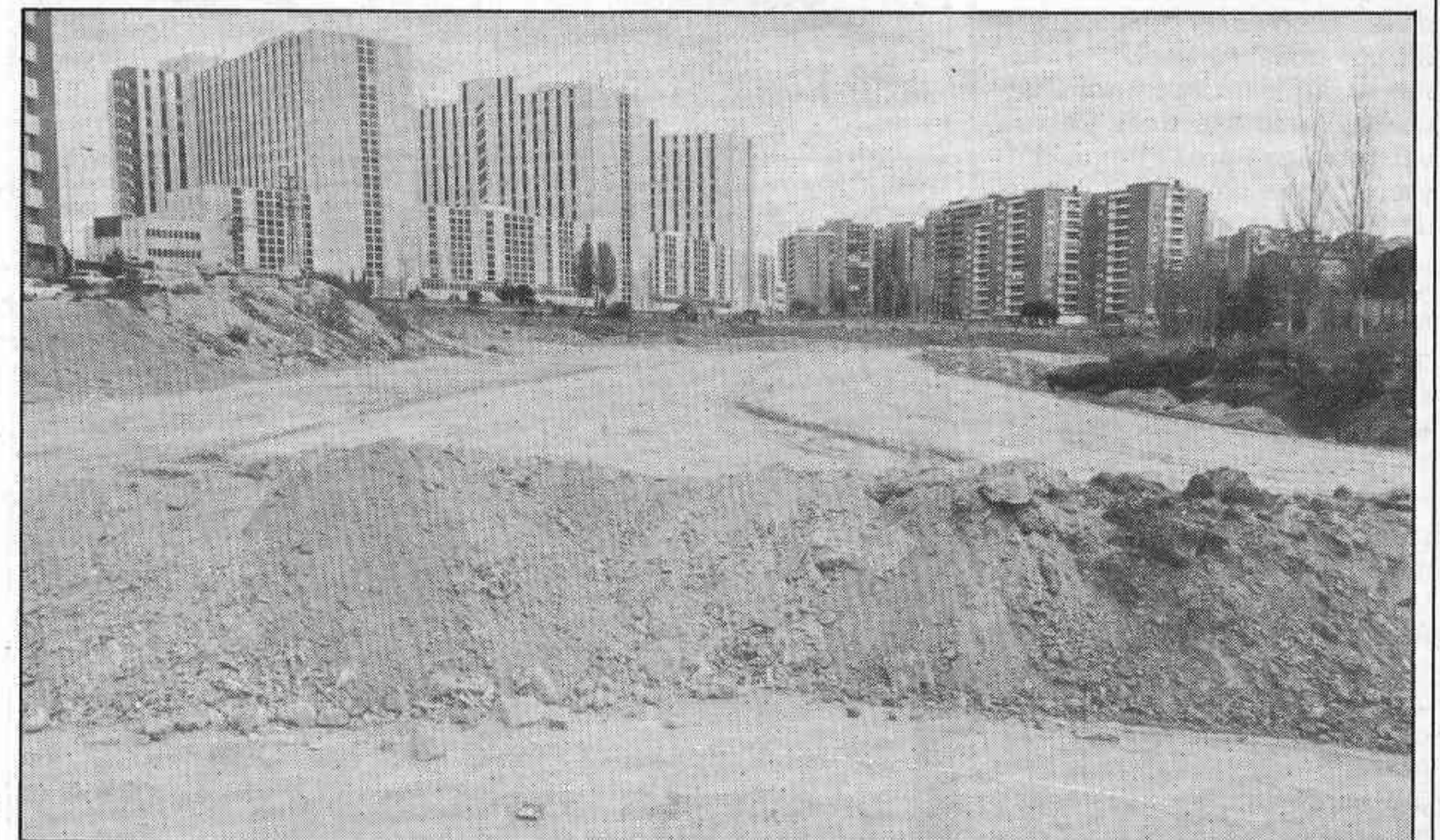
Aunque el plazo programado por la Administración para el comienzo de las obras es de tres años, el primer tramo de la avenida ya se ha adjudicado, y las obras ya se están llevando a cabo.
