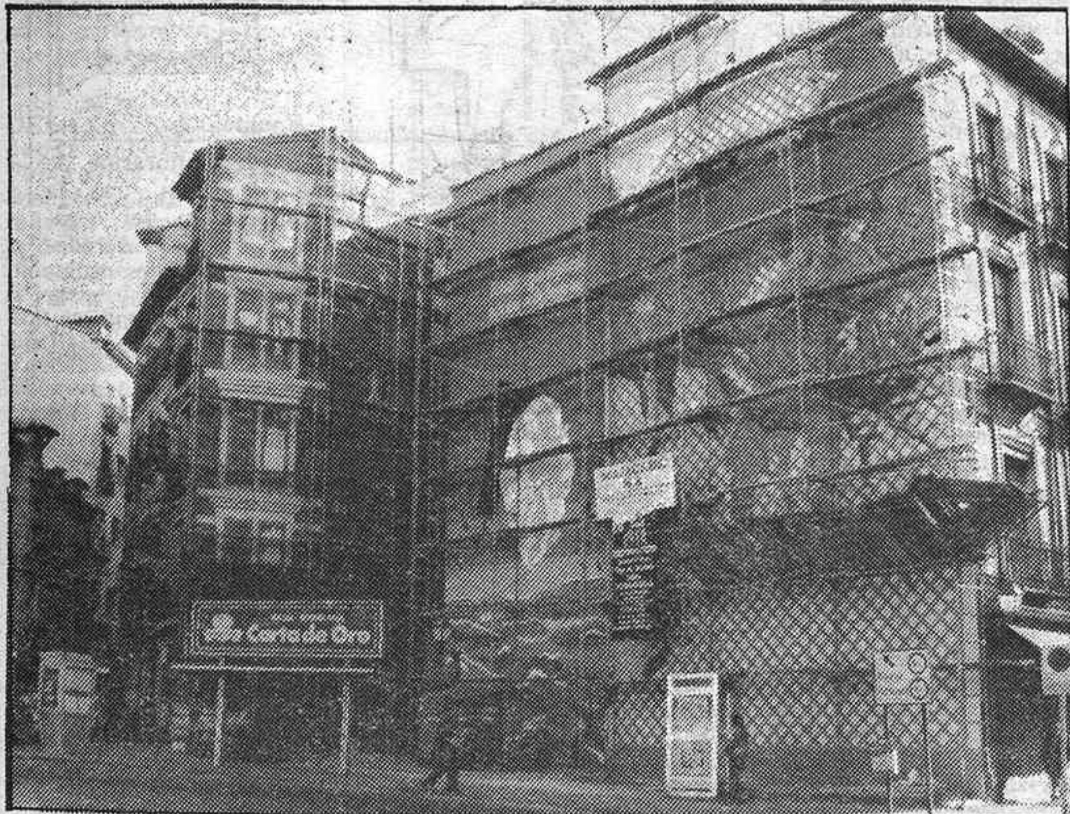
El plan general quiere hacer de Madrid una ciudad habitable. Con este espíritu, el Ayuntamiento lleva a cabo la restauración y decoración de medianerías en edificios de la zona centro, como estos de Puerta Cerrada
