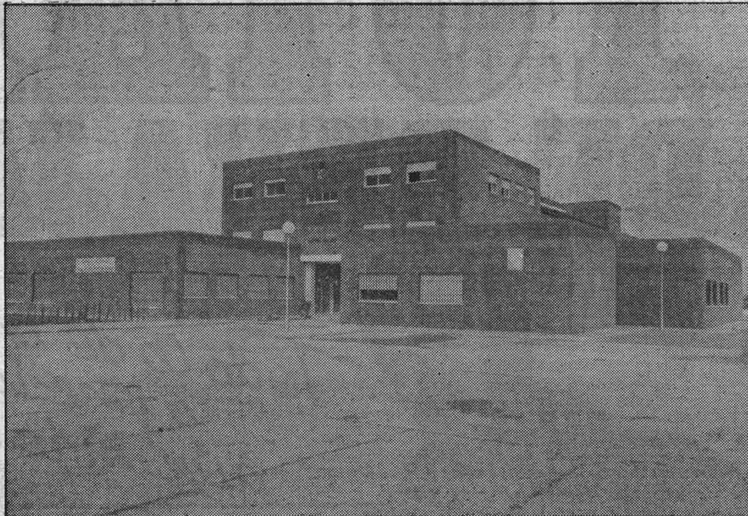
Perspectiva del Colegio Nuestra Señora del Perpetuo Socorro en Rota una vez finalizadas las obras
