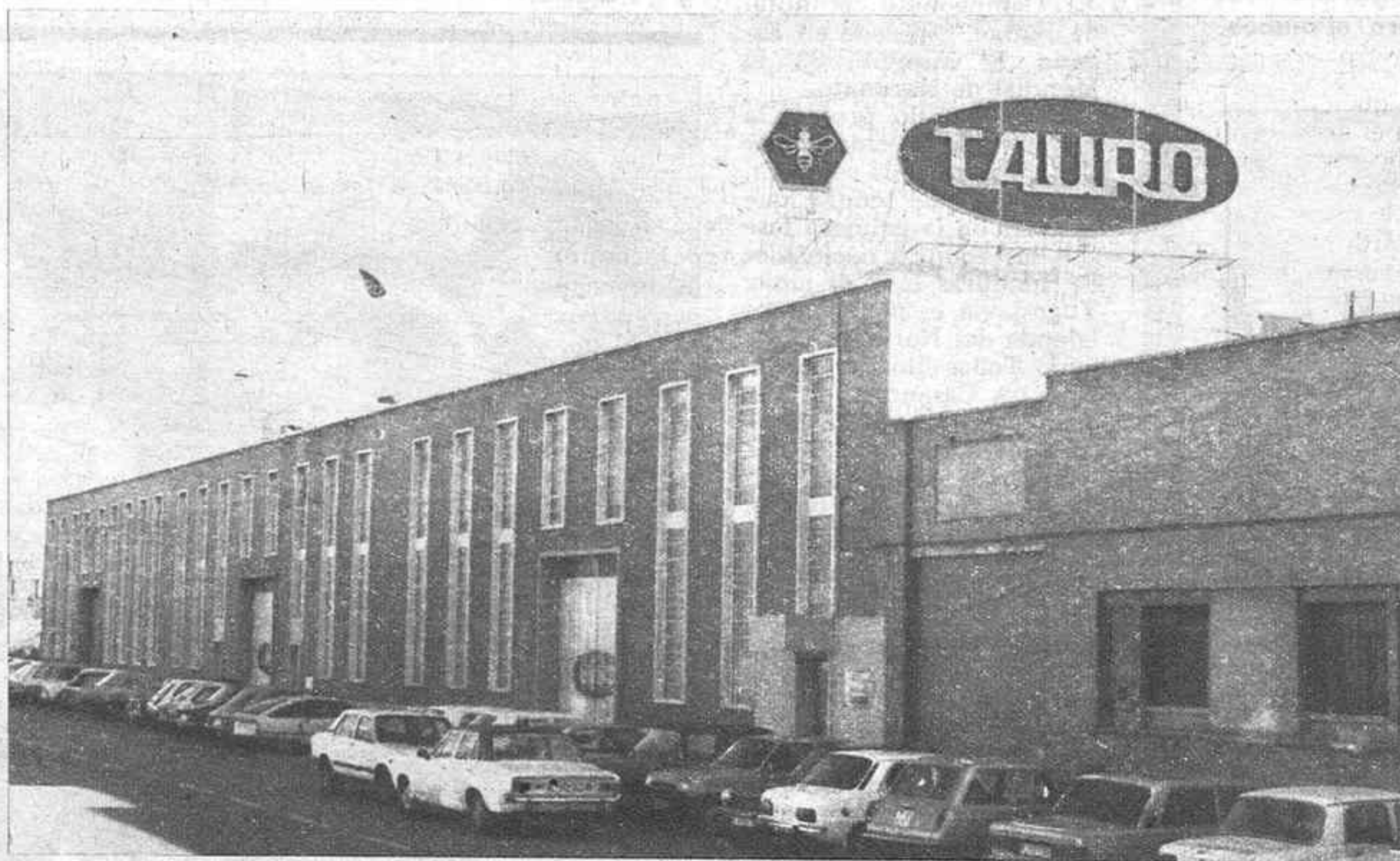
Perspectiva de las nuevas instalaciones de TAURO, S. A., en la calle Julián Camarillo, de Madrid
