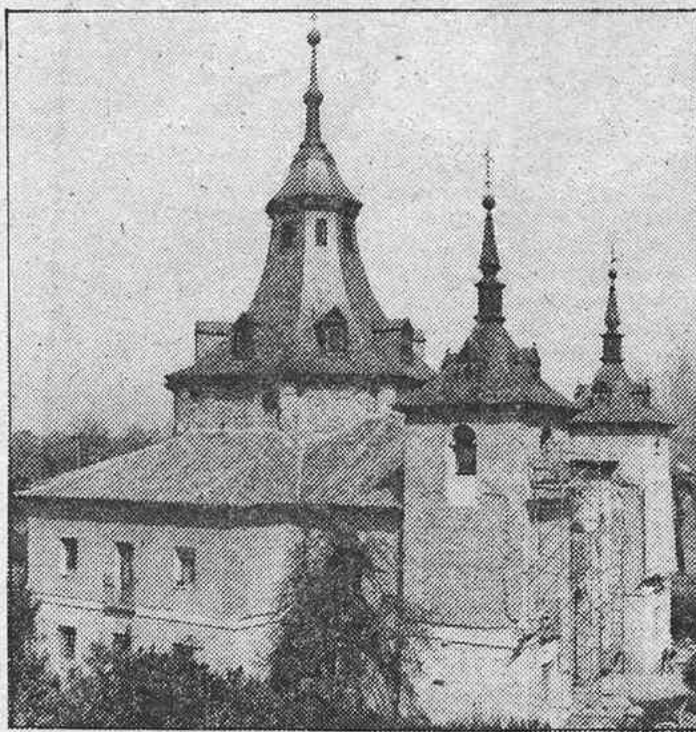
La ermita de la Virgen del Puerto, situada entre el Campo del Moro y la ribera del Manzanares, se halla en estos momentos sometida a unos trabajos de restauración en su parte externa. En una primera fase fue renovada la cubierta de las torres, y ahora se procede a la conservación del resto del edificio. La ermita de la Virgen del Puerto y su entorno constituyen uno de los parajes urbanos de mayor carácter y atractivo de Madrid
