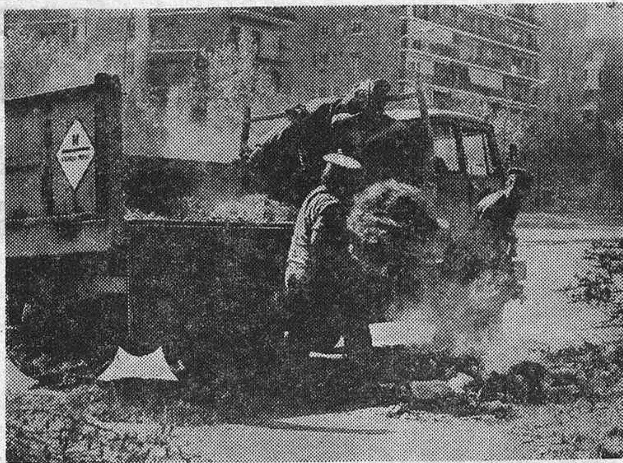
Se retiran los desperdicios de la vía pública
