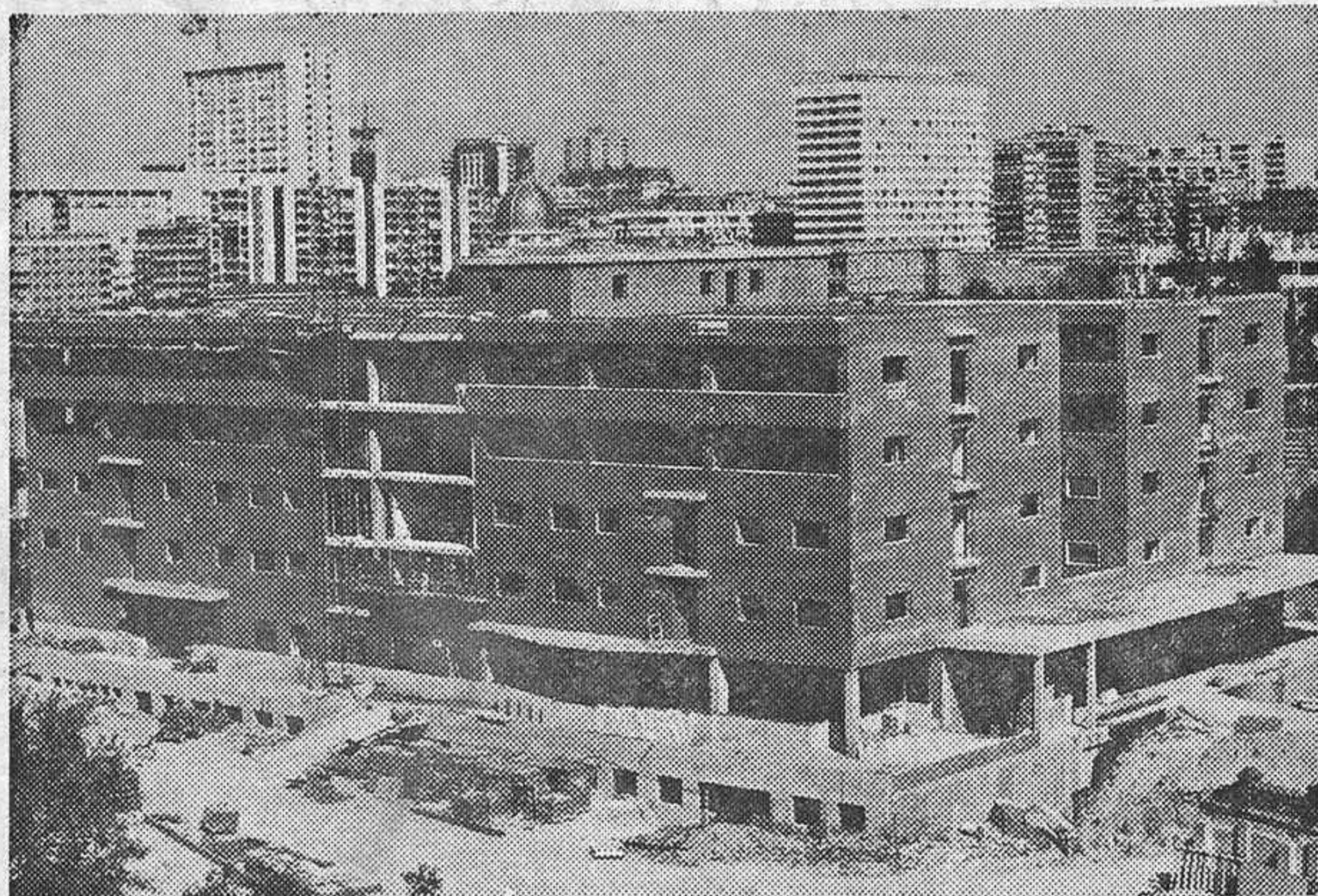
Así se encuentra de adelantado el edificio que se construye en la calle de Serrano que servirá para el Albergue del Necesitado, regentado por los Hermanos de San Juan de Dios. (Torremocha.)
