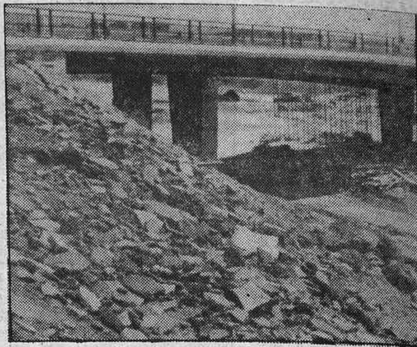
La construcción y ensanche de puentes ha sido una de las acciones prioritarias llevadas a cabo por la Diputación
