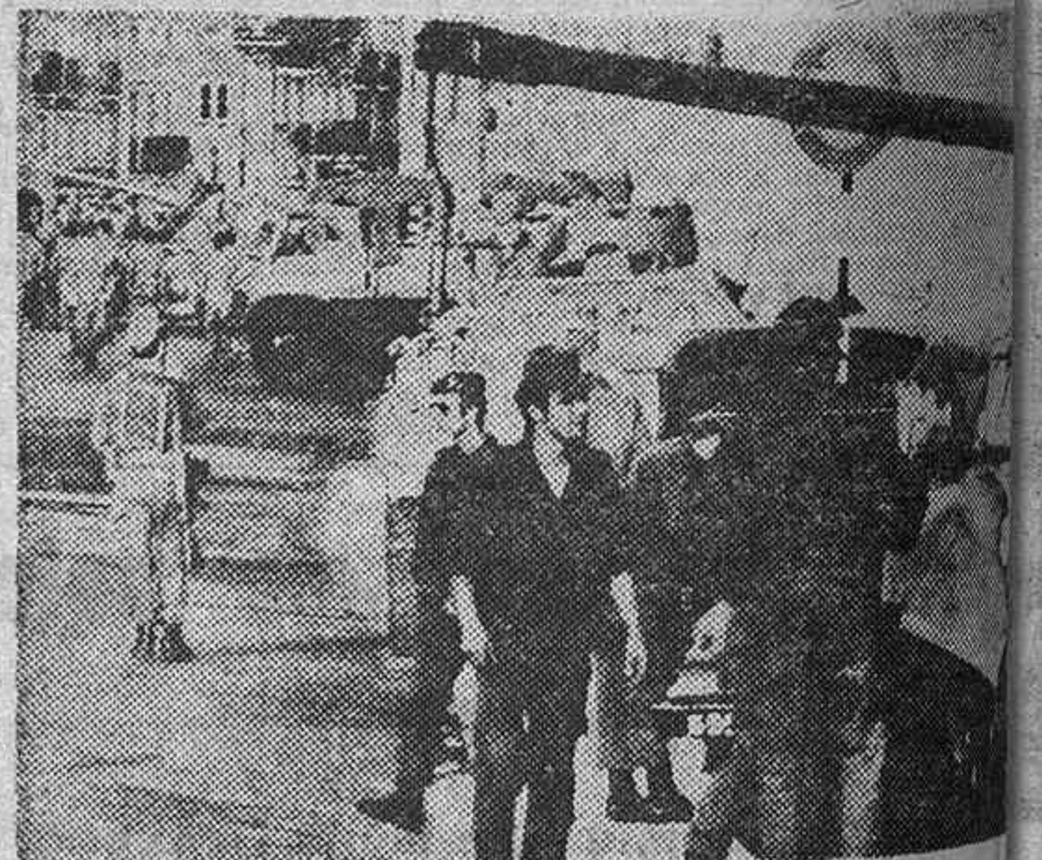
Tanques en las calles lisboetas
