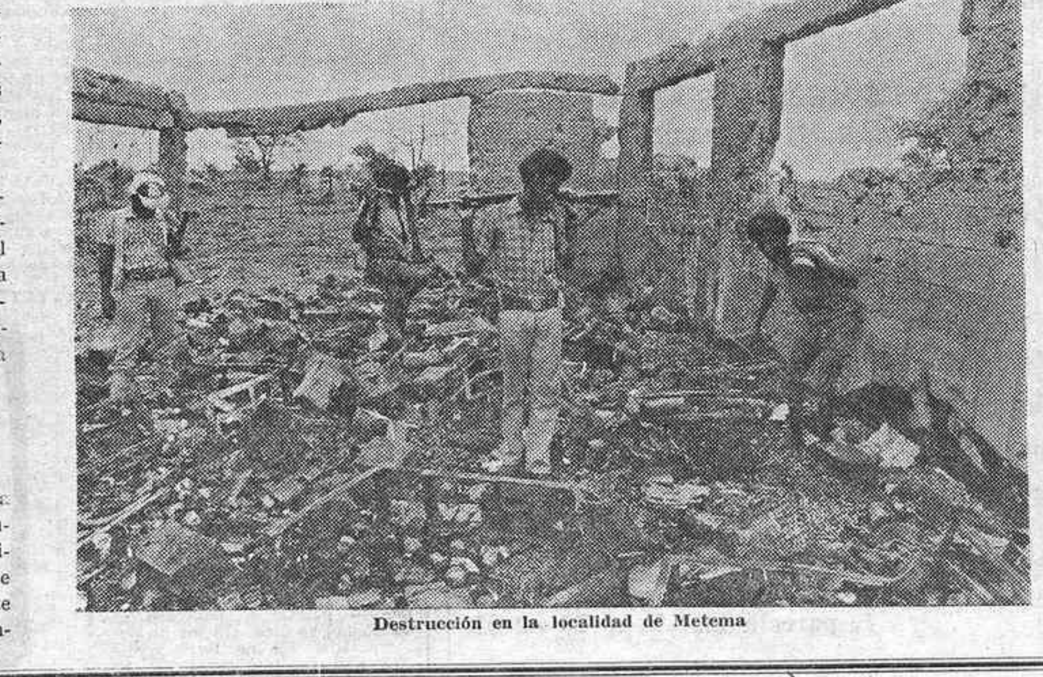
Dstrucción en la localidad de Metema
