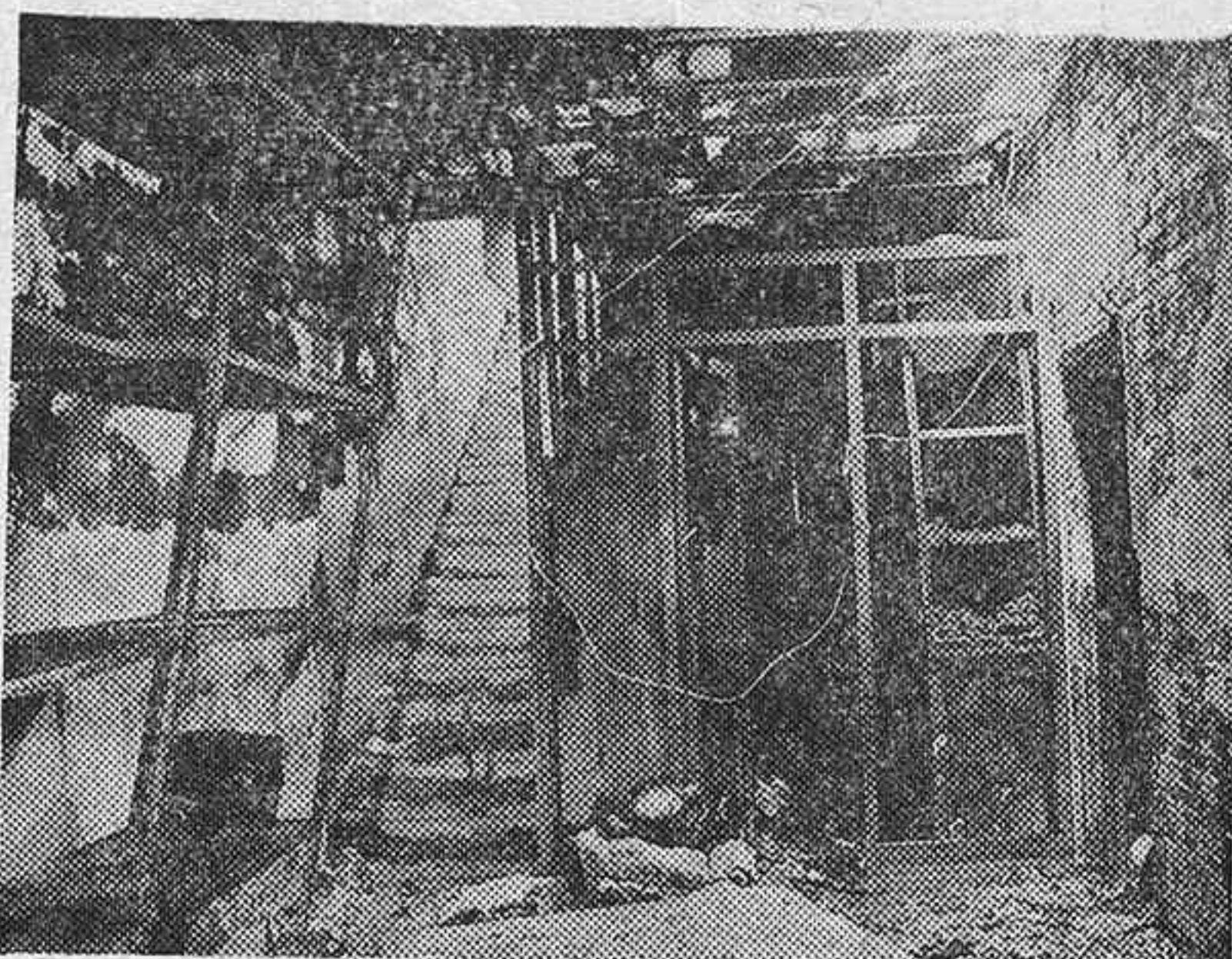
A dieciocho millones de pesetas se elevan las pérdidas ocasionadas por un incendio que destruyó una fábrica de prendas de nylon en Lérida. Así quedó el interior de la nave industrial.
