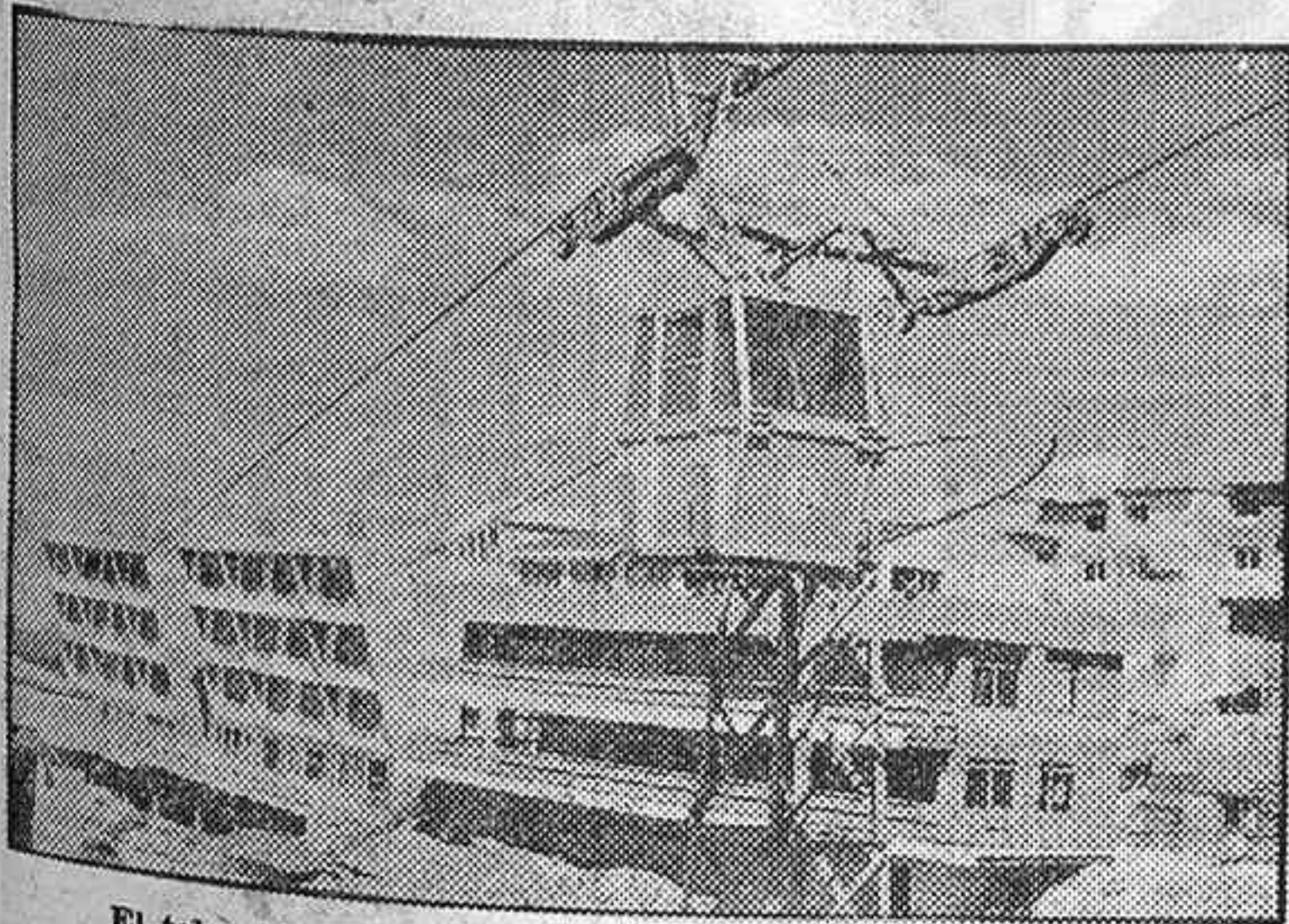
El telecable pasa por delante del grupo de apartamentos y de la cafetería y salón (bloque de la derecha), que quedará unido al hotel, construido detrás
