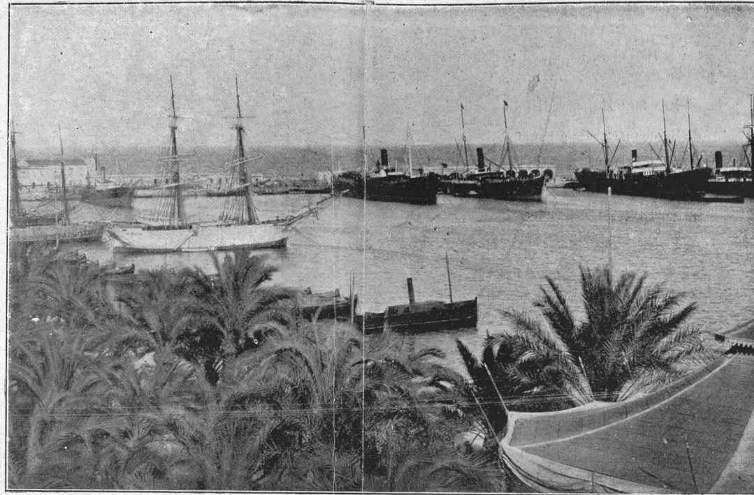
VISTA DEL PUERTO DESDE EL PASEO DE LOS MÁRTIRES.
