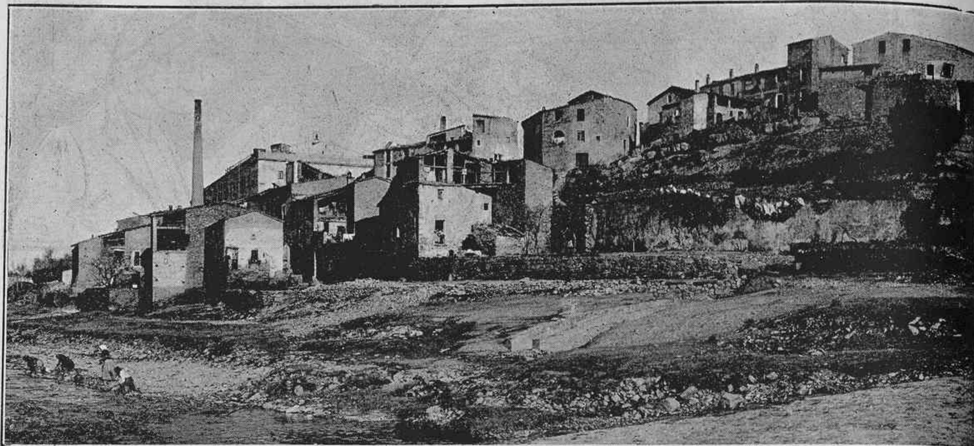
PONT DE VILUMARA, barri fabril agregat al poble de Rocafort.
