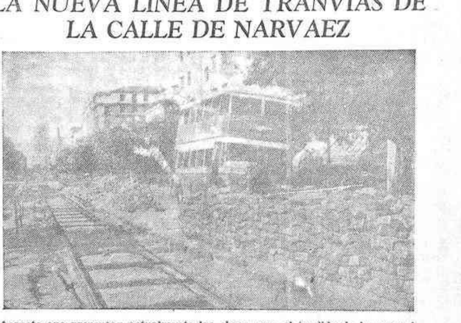
Aspecto que presentan actualmente las obras para el tendido de la nueva línea de tranvías que ha de unir el populoso barrio de Narvaez con el centro de Madrid. En la foto destaca el autobús que viene realizando este servicio (Foto Cifra.)
