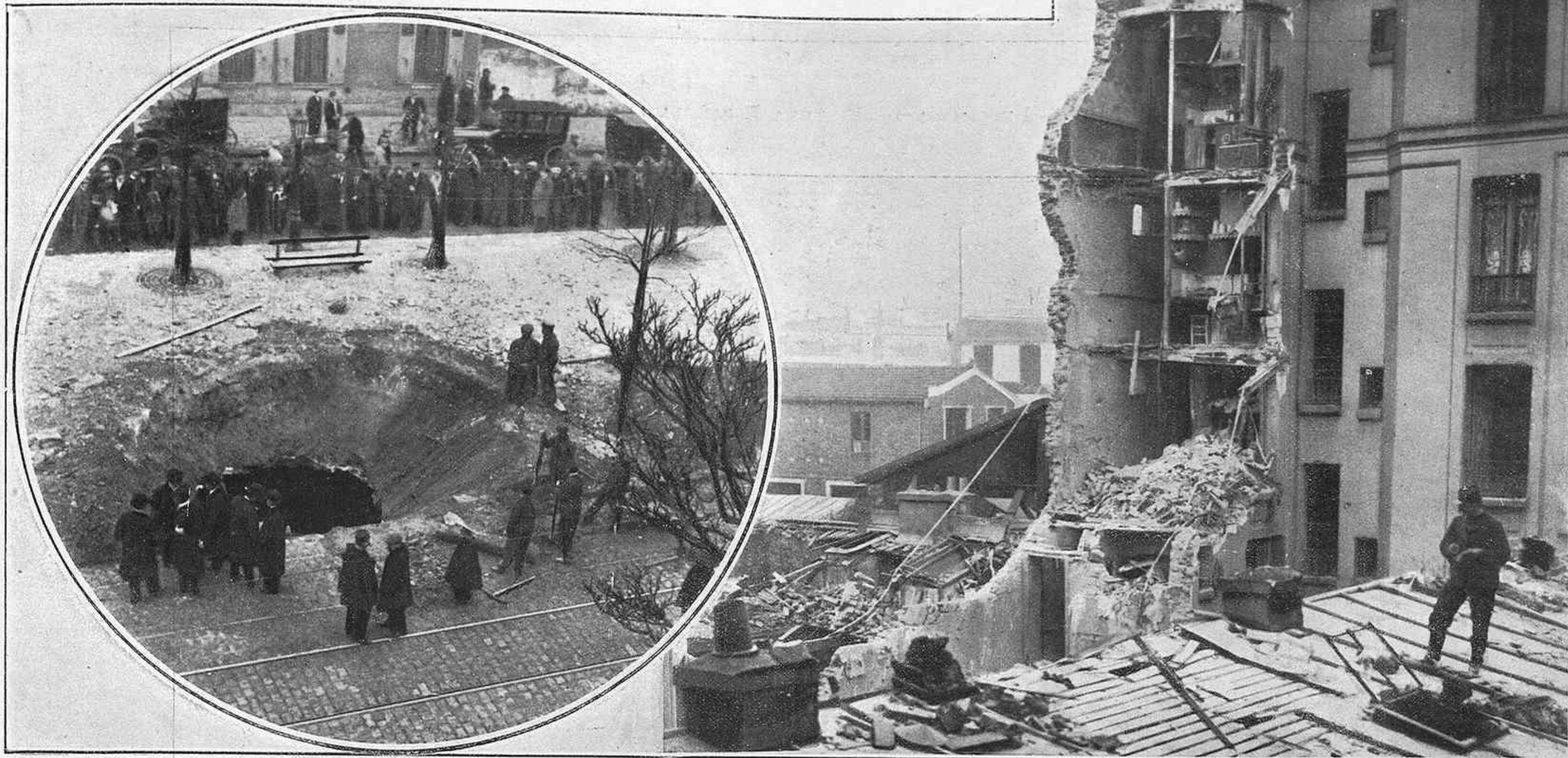
La bóveda del Metropolitano hundida por una bomba. — Casa de cinco pisos partida por una bomba en dos partes, de las cuales la posterior se derrumbó (De fotografías de Branger y Chusseau-Flaviens.)
