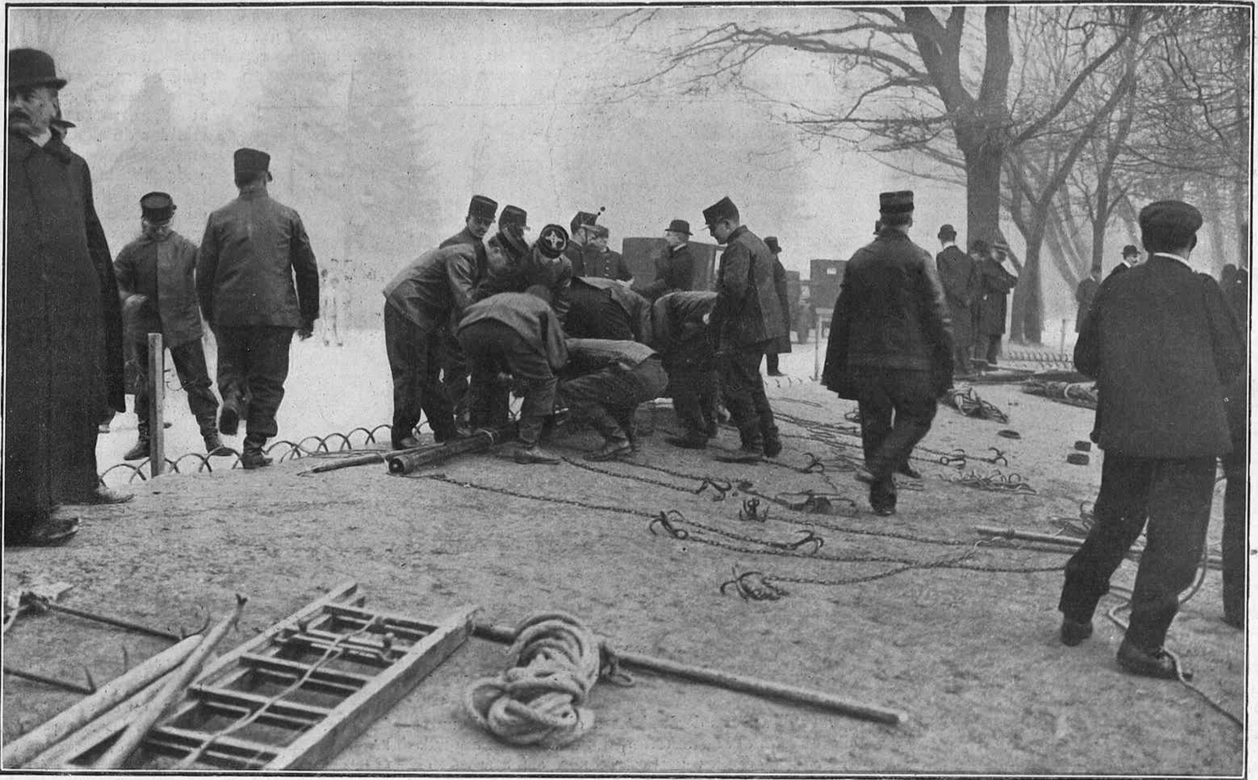
París.—El accidente del lago del Bosque de Bolonia. Trabajos para extraer del agua los cadáveres (De fotografía de M. Rol y C. a )
