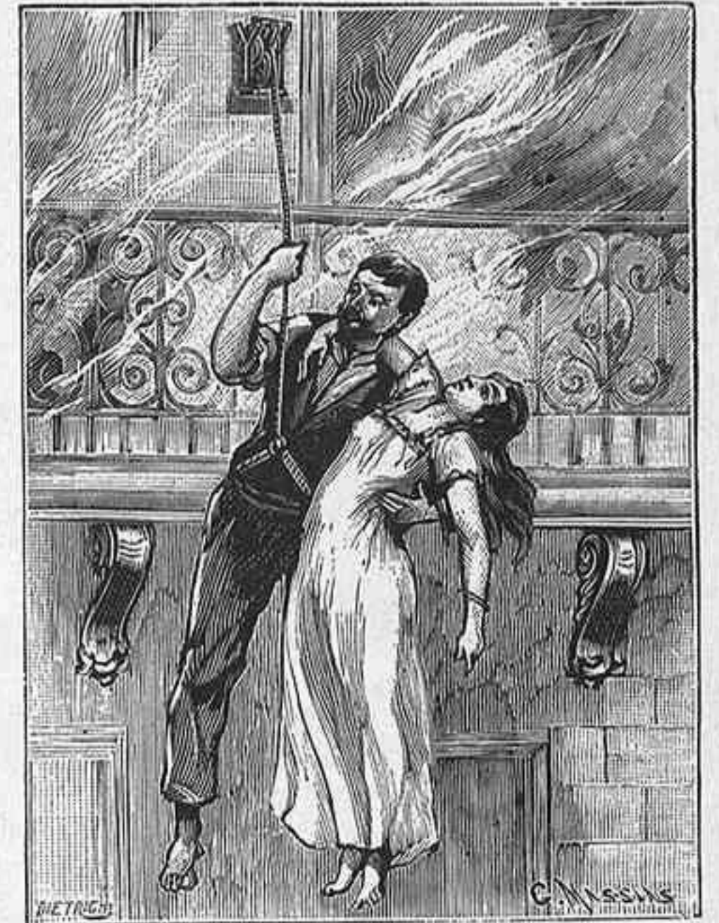
El descensor automático en función durante un incendio.
