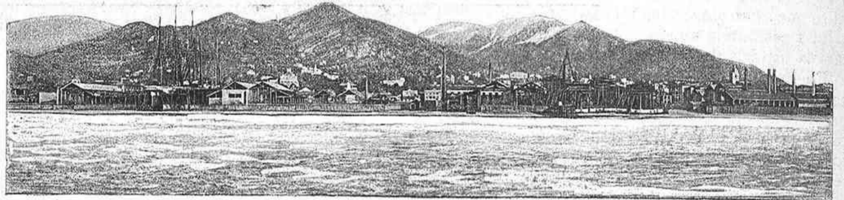
TALLERES DE LA CASA ANSALDO Y C. a , DE GÉNOVA. - Vista del astillero naval de Sestri Ponente
