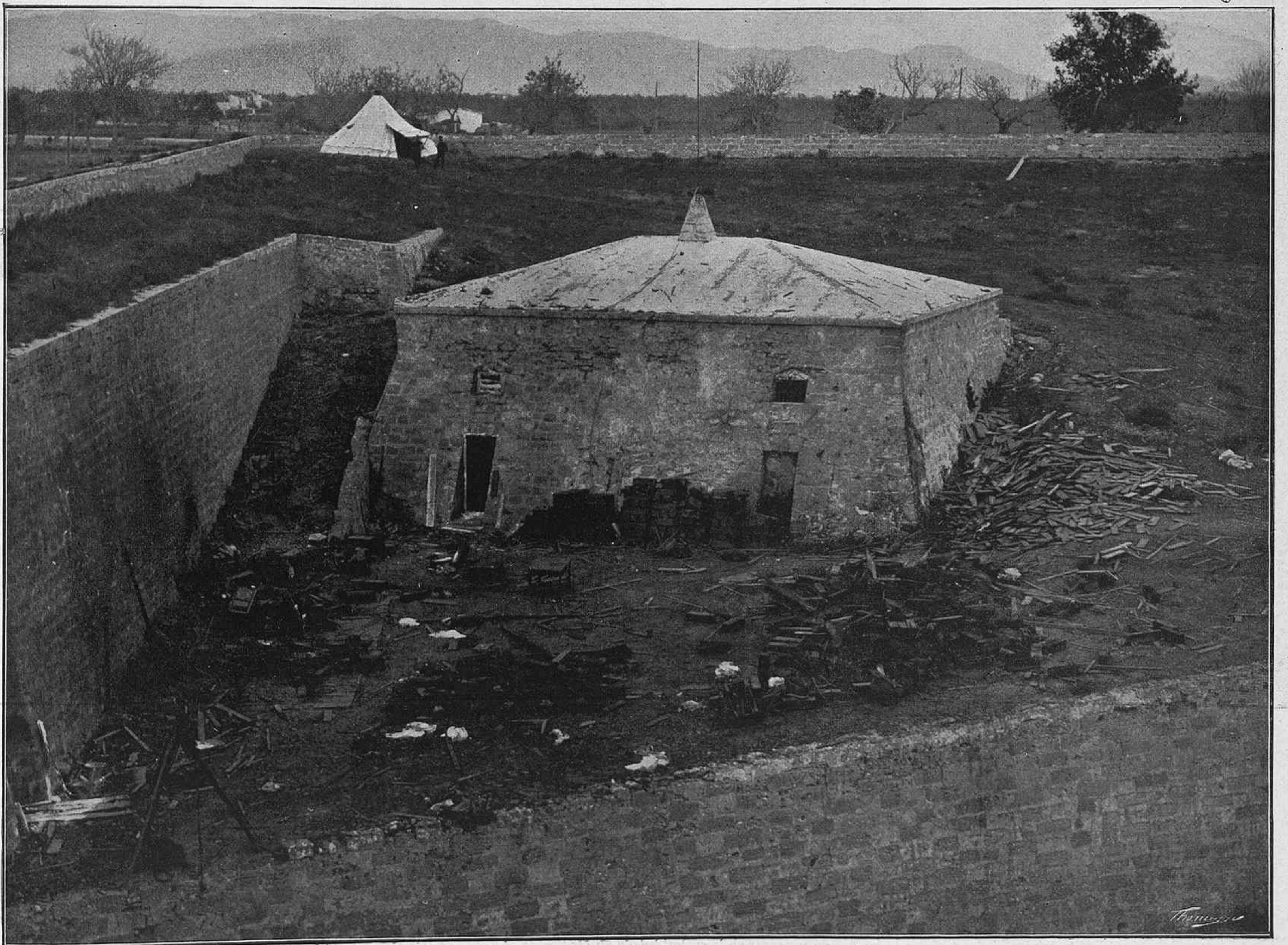
PALMA DE MALLORCA - EL POLVORÍN DE JAIME I EN EL REBELLÓN DE SAN FERNANDO DESPUÉS DE LA EXPLOSIÓN OCURRIDA EL DÍA 25 DE NOVIEMBRE ÚLTIMO (De fotografía del Sr. Truyols, de Palma)
