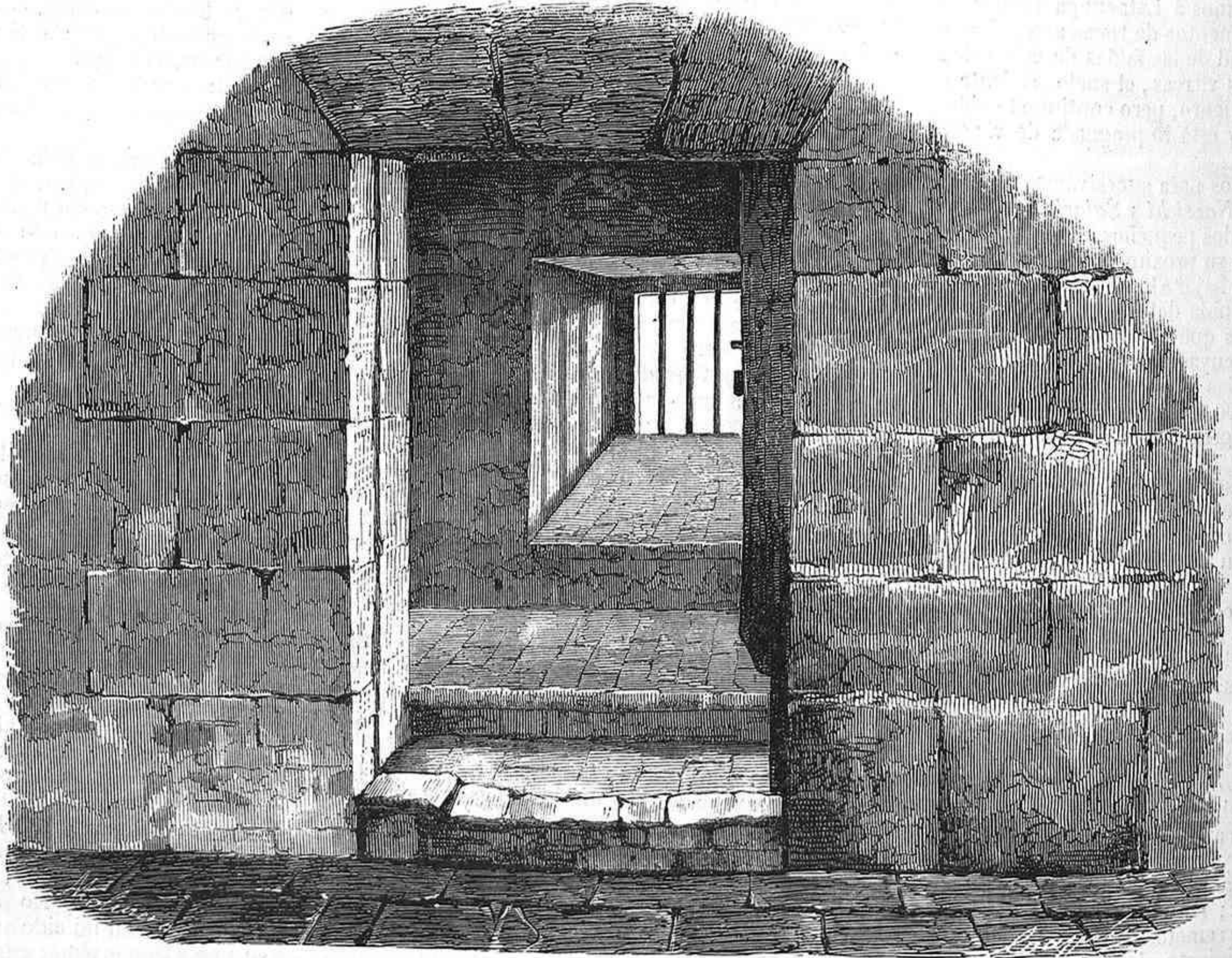
SANTO DOMINGO.—VISTA EXTERIOR DE LA PRISION DE CRISTOBAL COLON, EN LA TORRE DEL HOMENAJE.
