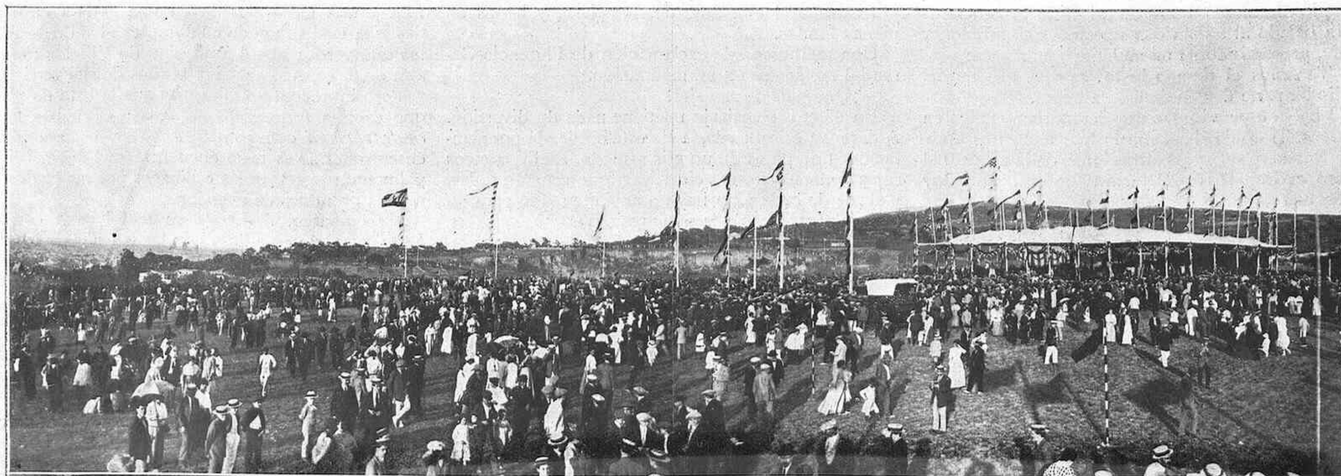
Aspecto que ofrecía una parte de la montaña de Montjuich el día de la inauguración de las obras de urbanización
