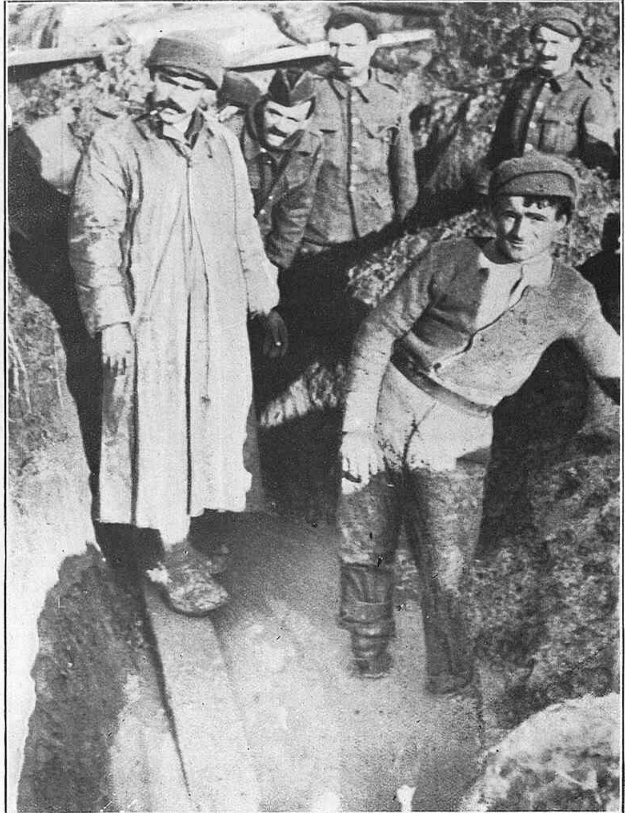
Trinchera inglesa inundada por las lluvias
