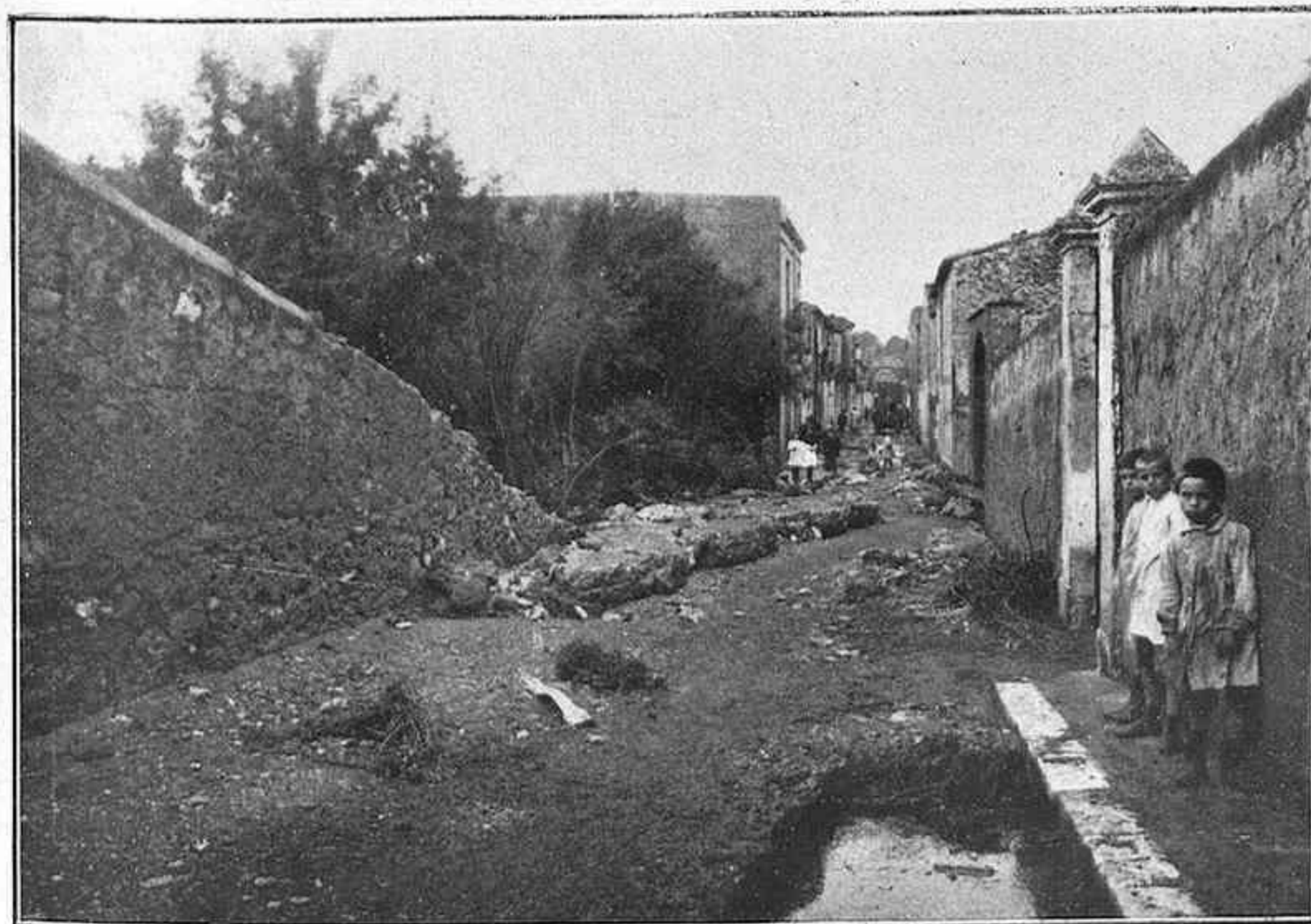
Una calle en que el agua alcanzó la altura de dos metros
