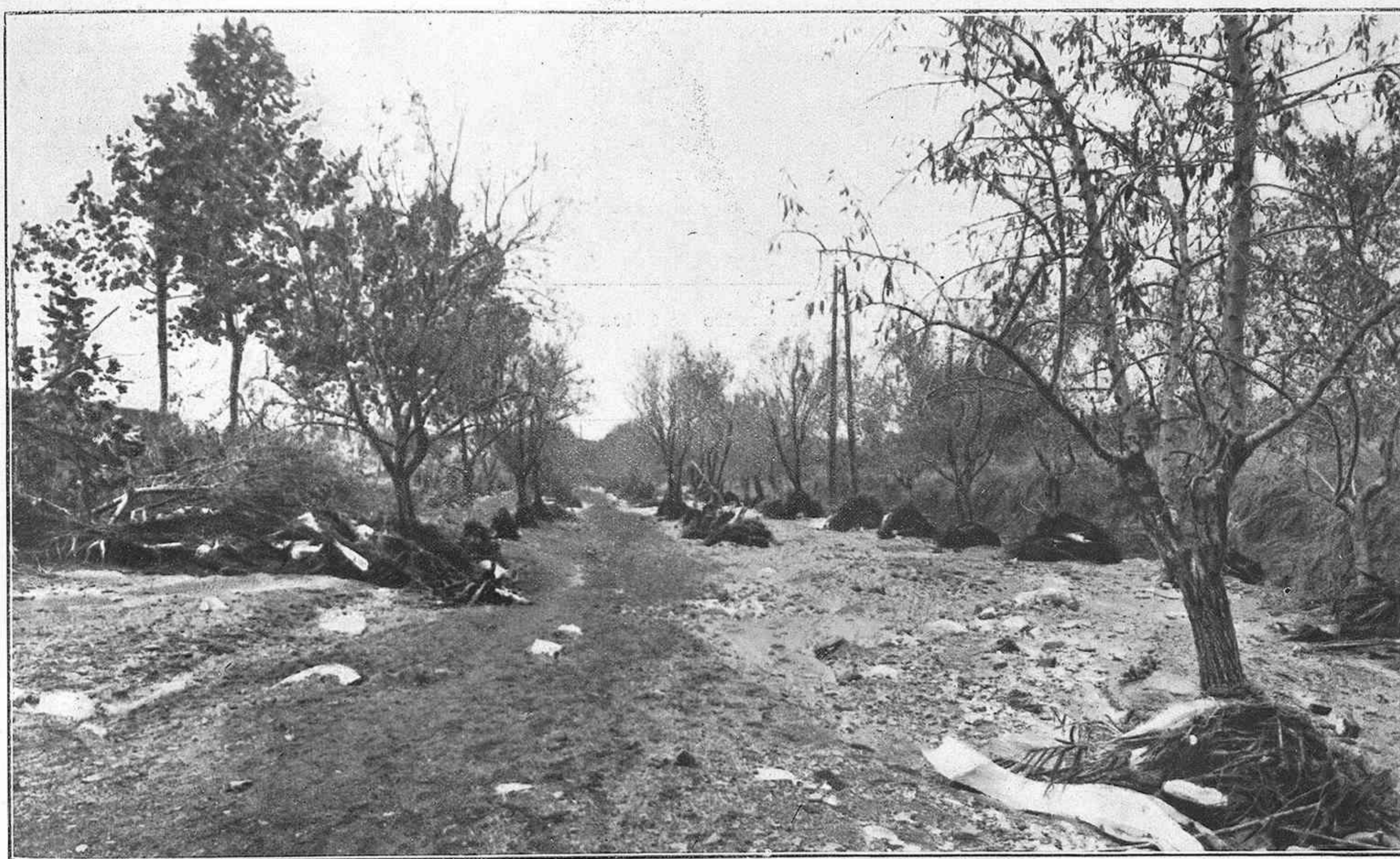
Paseo devastado por la corriente de las aguas
