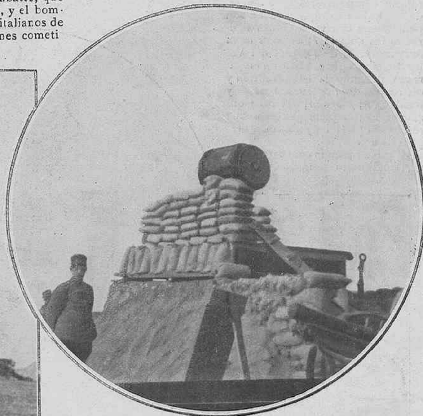
Reducto avanzado construido en Gargaresch Encima del reducto se ve un proyector eléctrico
