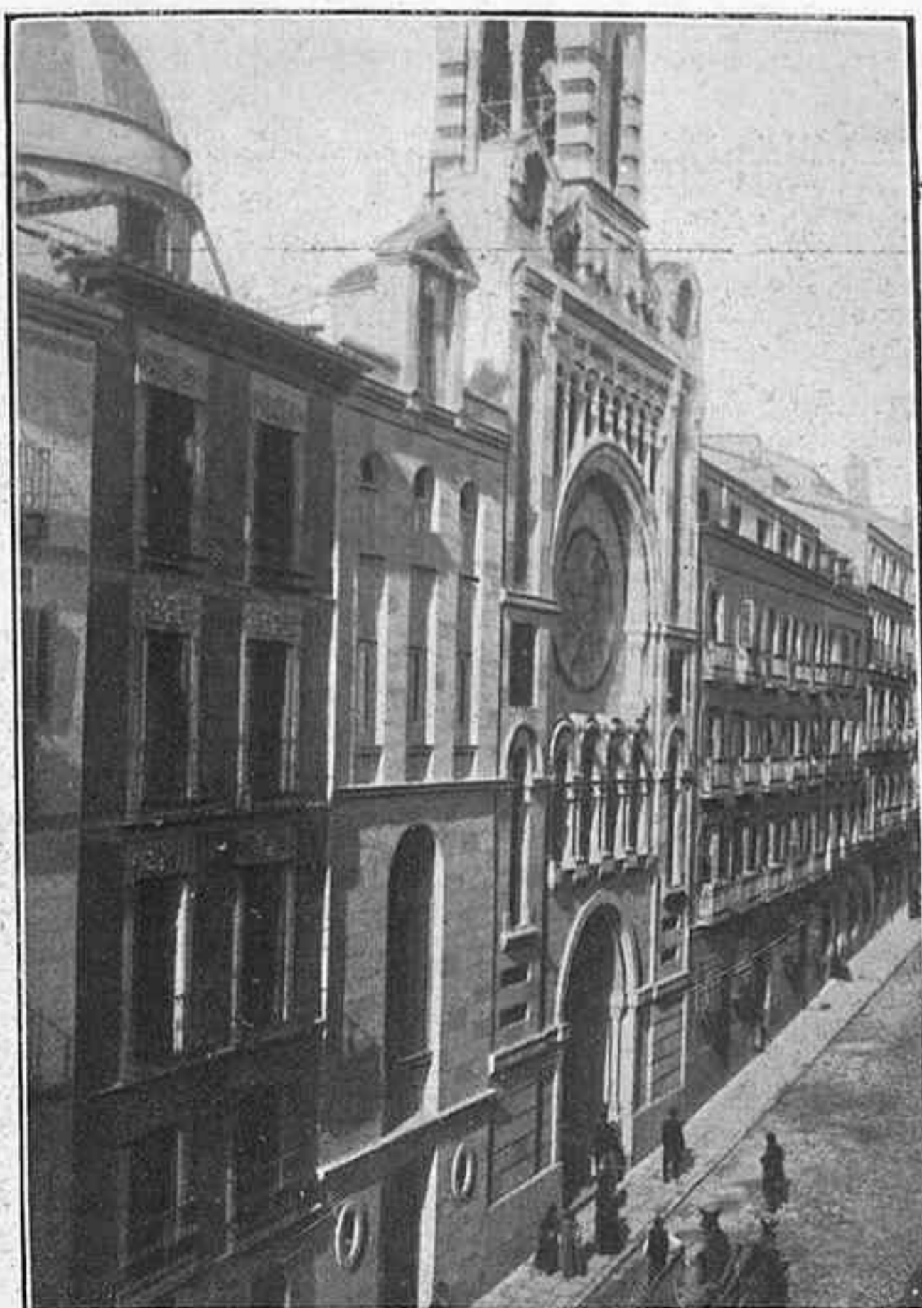
Fachada principal de la calle de Valverde
