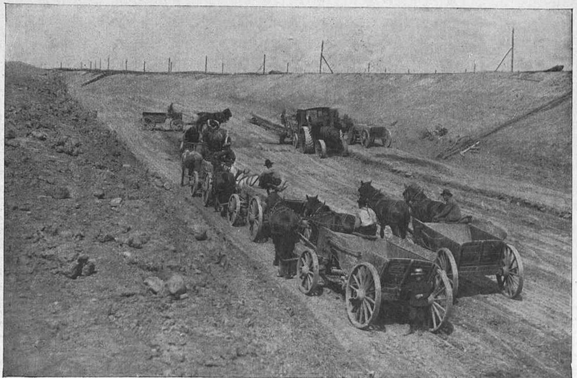
Elevación de los declives del canal principal por medio del vapor
