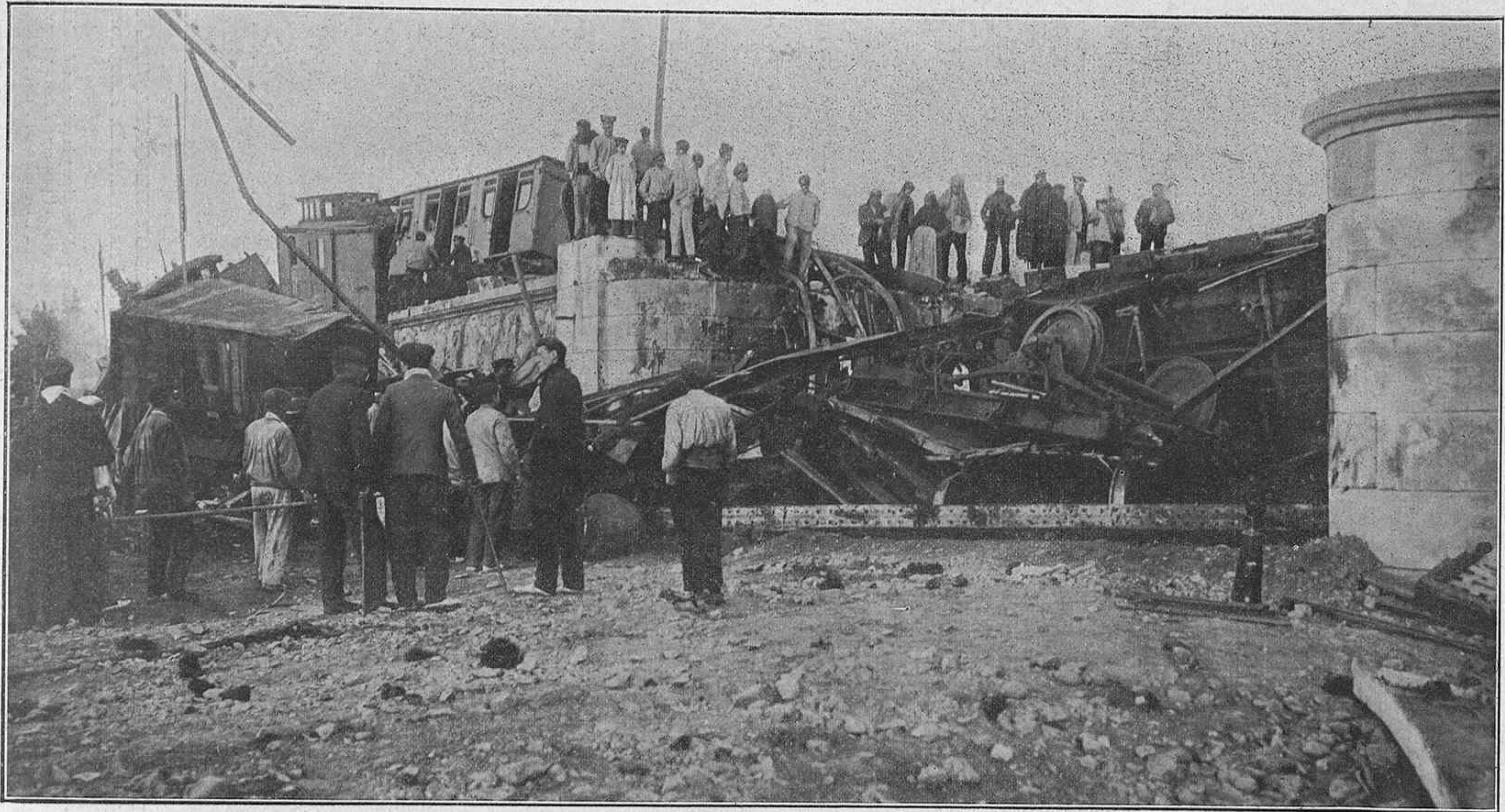
Vista del sitio de la catástrofe poco después de ocurrida ésta. En ella se ven los vagones enteramente destruidos y volcados, y el tablero y los rieles del puente rotos y retorcidos. A la izquierda, sobre la vía, la máquina, el ténder y dos vagones descarrilados. (De fotografía de Castellá.)
