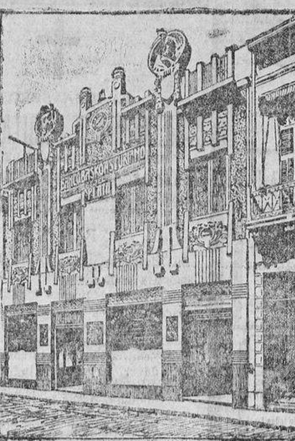
EDIFICIO DEL BANCO
