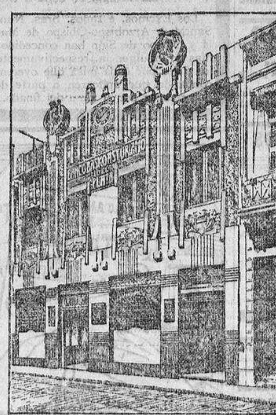
EDIFICIO DEL BANCO
