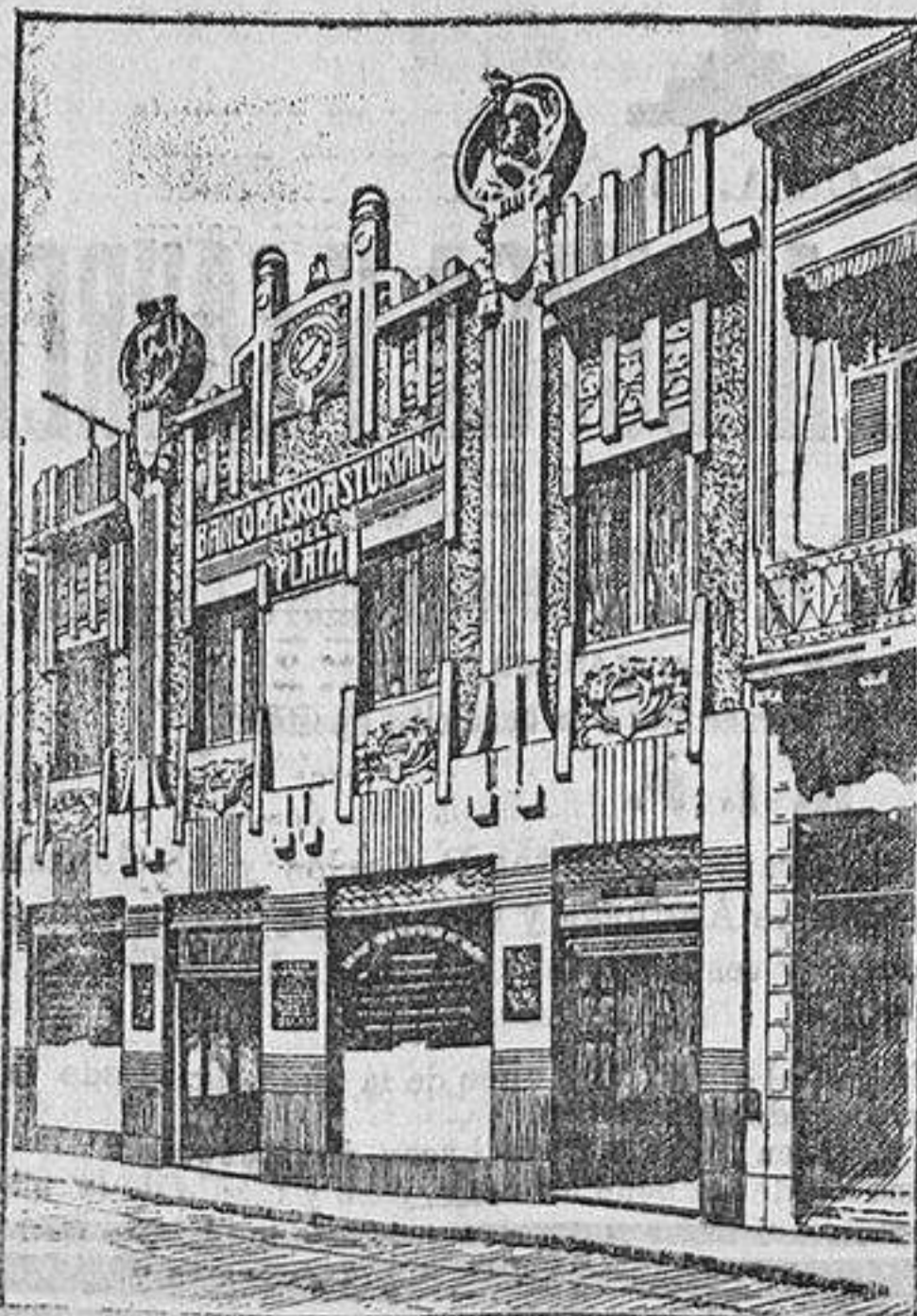
EDIFICIO DEL BANCC
