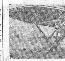
Nuevo avión construido Eart Mc Clary en Long-Beach (California). Las alas ran sido reemplazadas por un planotónico, bajo el cual estan us a ados el motor y el camarote de pasajeros. La hélice funciona en una abertura practicada en el plano. El constructor confía en llevar dobl del peso que puede elevar un avión de forma usual.
