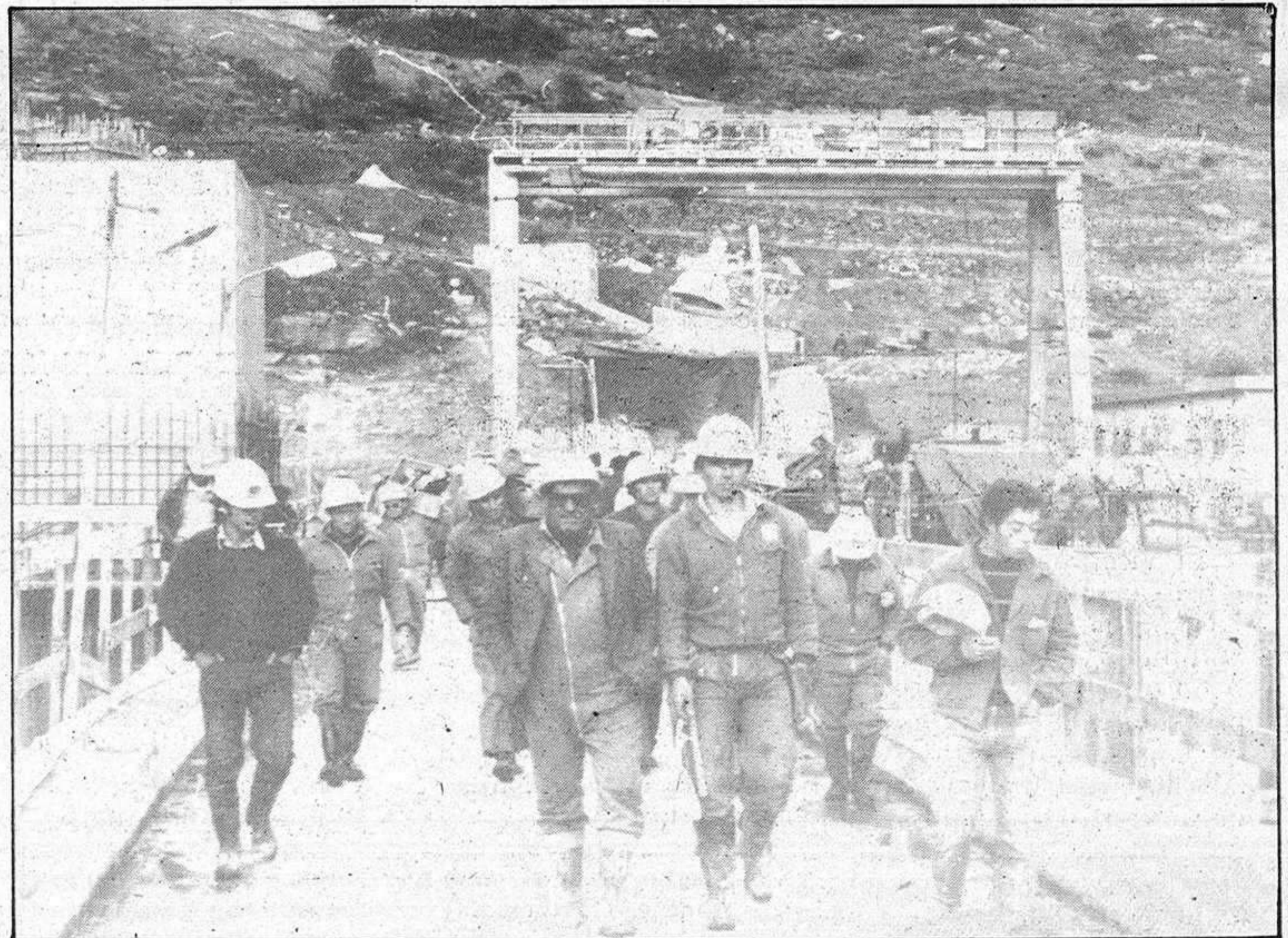
Un grupo de trabajadores abandona sus puestos de trabajo
