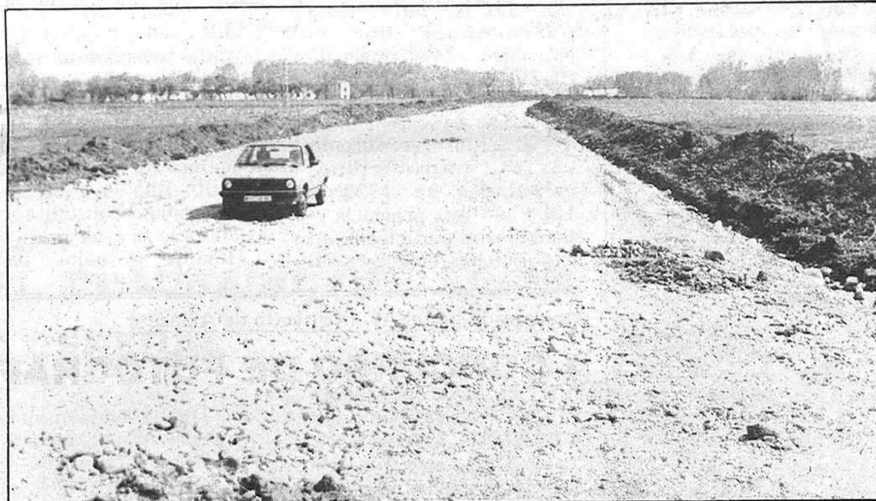
Como se puede apreciar en la fotografía, el estado de las obras era muy avanzado
