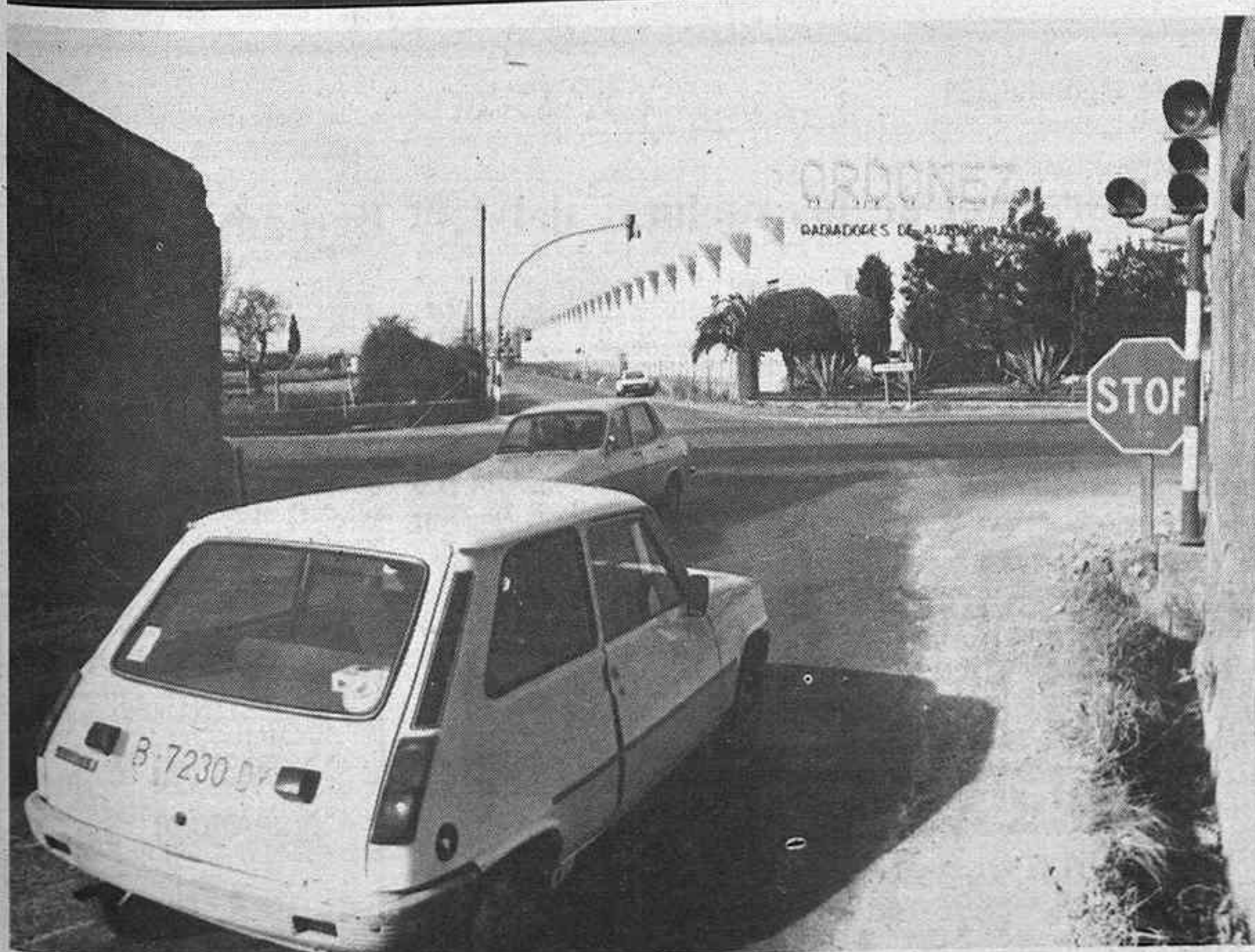
En la carretera de Ribesalbes, en su cruce con la nacional 340, se hará un paso inferior
