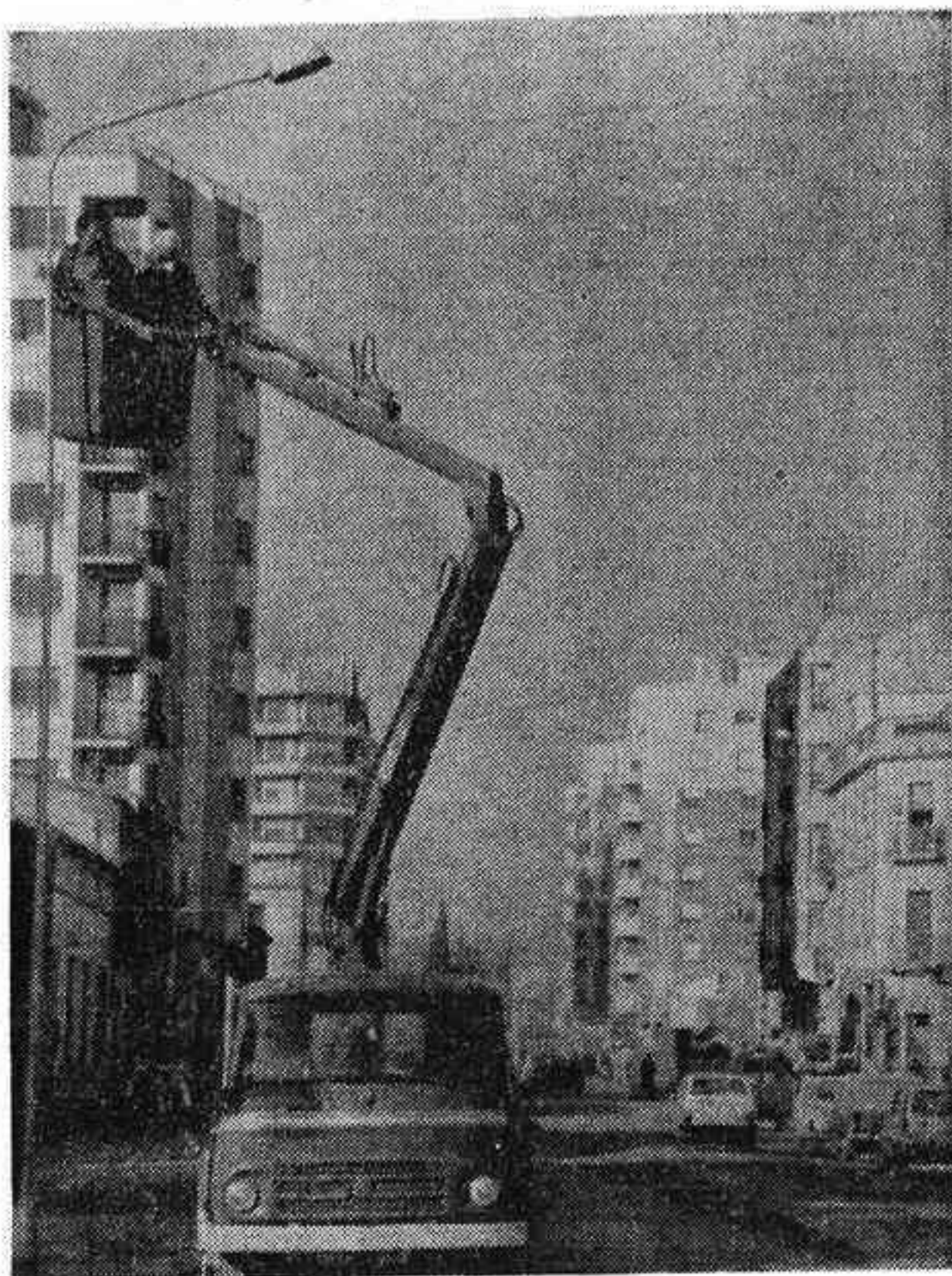
Una brigada municipal procede a desmontar los báculos del alumbrado público situado en la zona de obras
