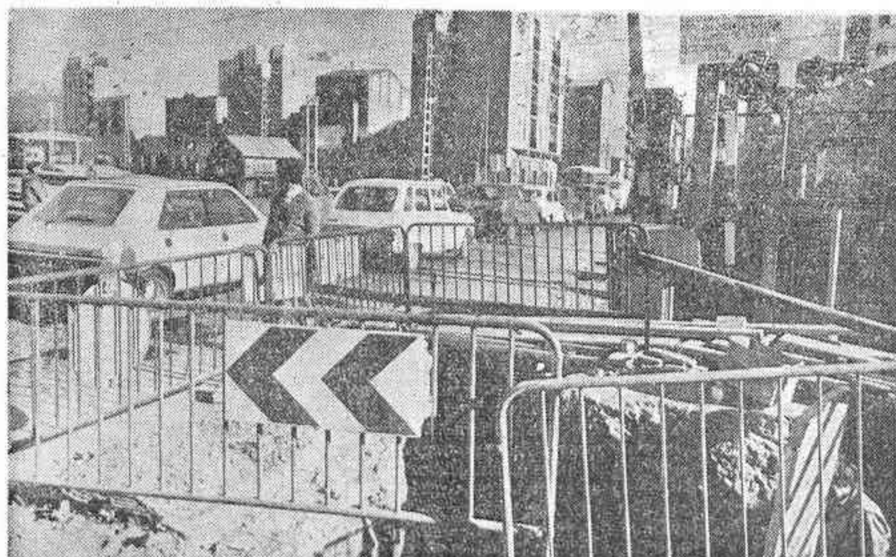
Todas las obras que hasta ahora se han realizado en el paso a nivel de la carretera de Alcora son de carácter complementarios (nuevo alcantarillado, agua potable y demoliciones), pero los trabajos fundamentales del proyecto todavía no han dado comienzo. — (Foto: HEREDIO)
