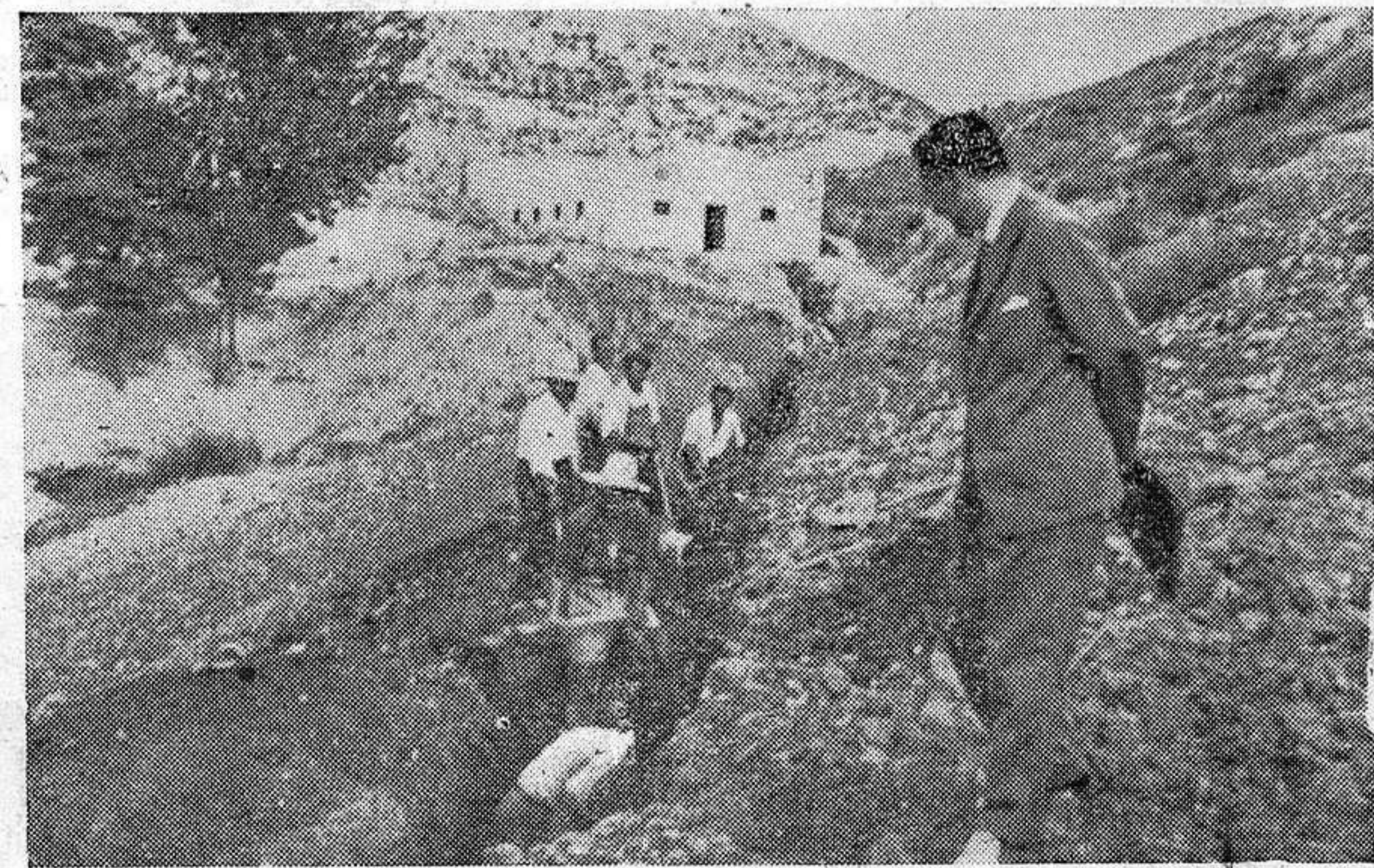
17 Julio: Las brigadas municipales trabajan activamente en la batalla del agua. Desde la posadora de Torija se abren zanjias para sustituir la vieja tubería obstruida por tobas calizas que impiden la llegada del preciado líquido a nuestros hogares.
