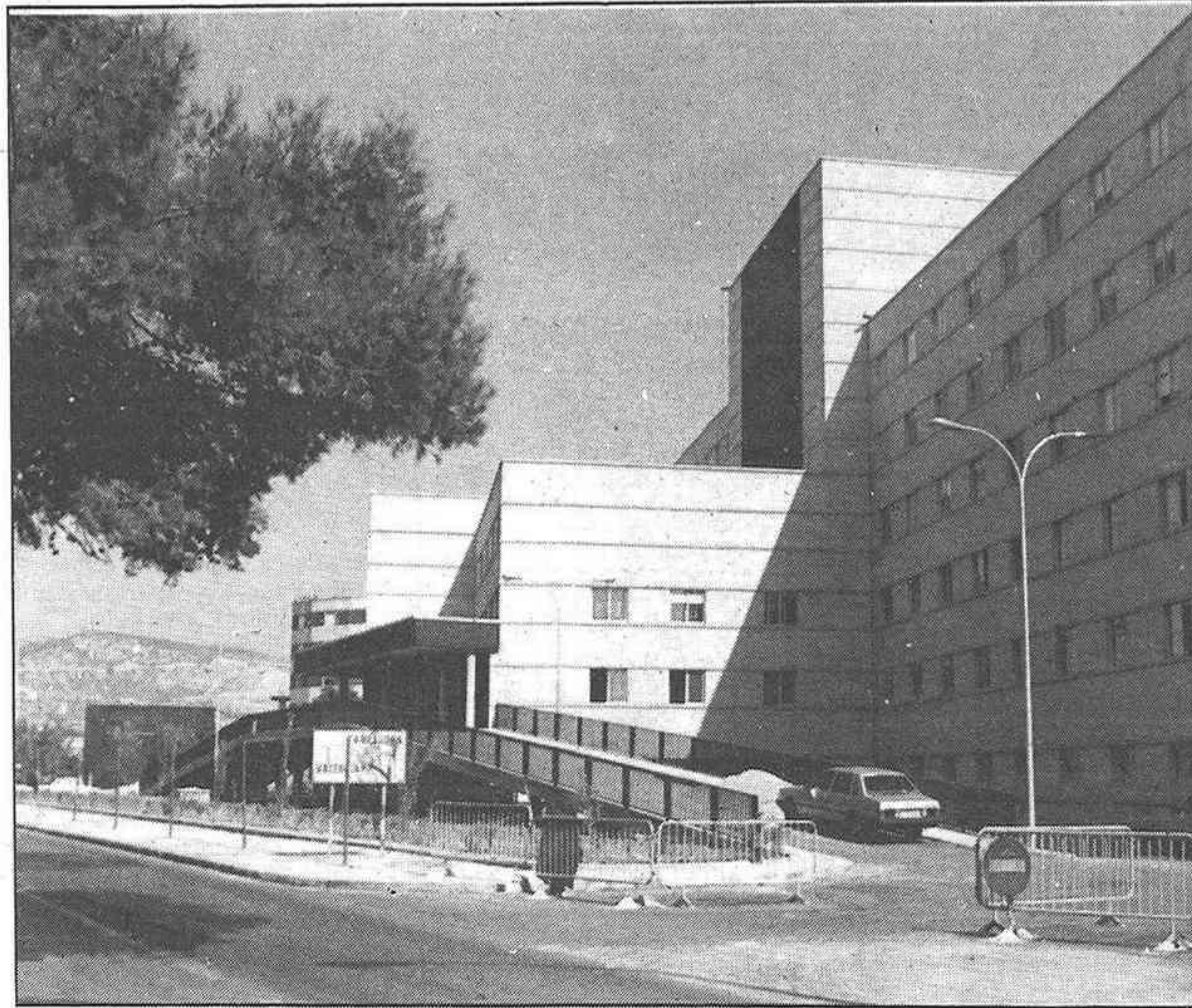
Las obras del nuevo hospital están prácticamente finalizadas / V. GAMIR
