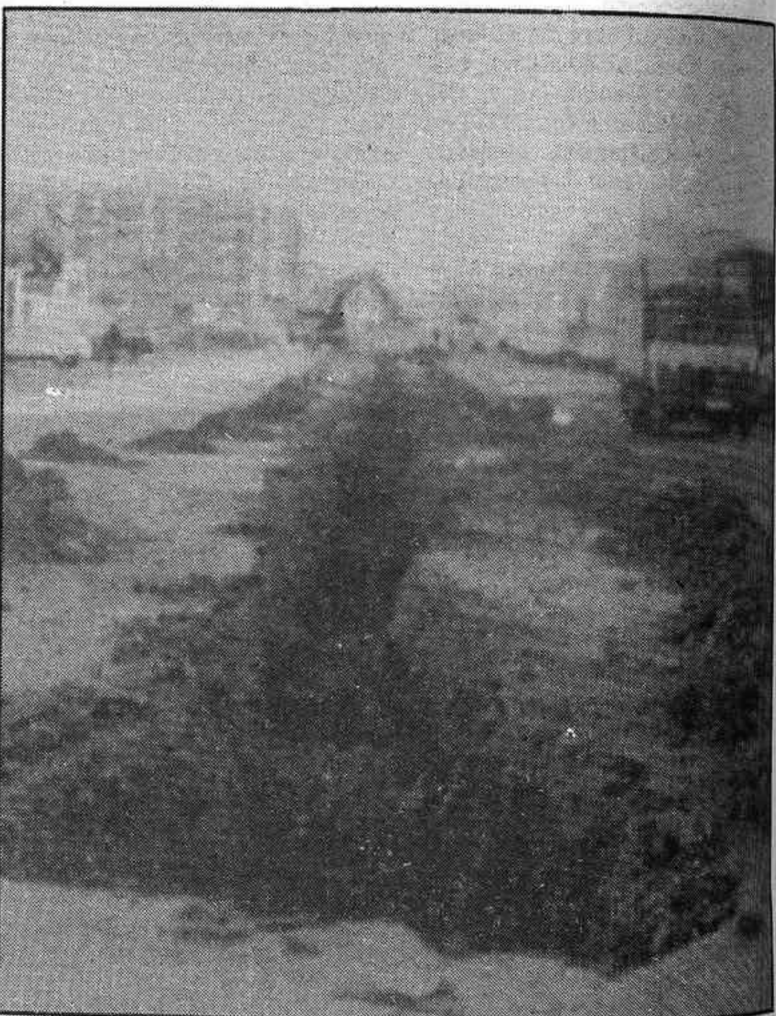
Las obras siguen de forma acelerada
