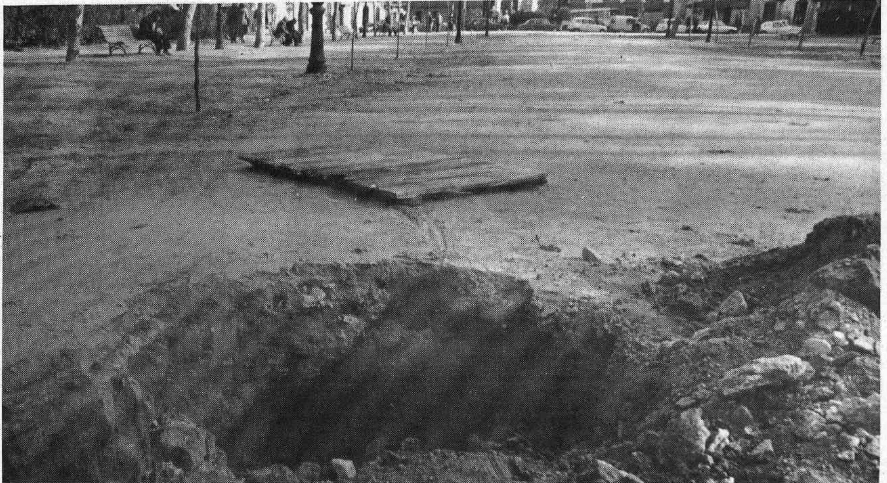
Socavón producido en el Paseo de Coches de Ribalta.
