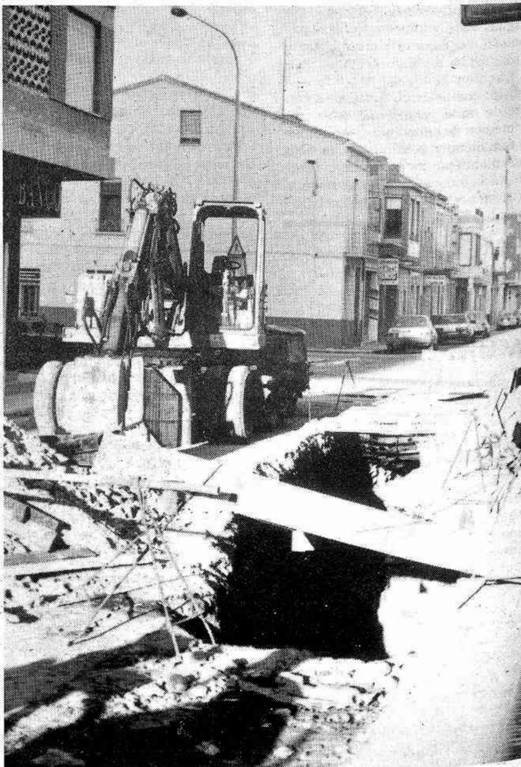
Obras de las instalaciones subterráneas
