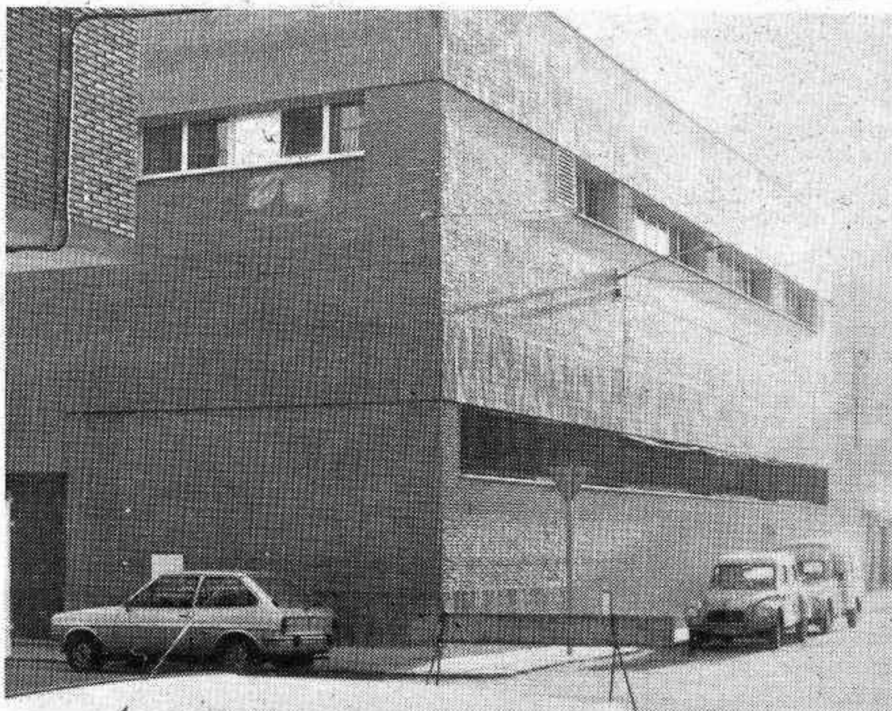
Edificio de la nueva central telefónica
