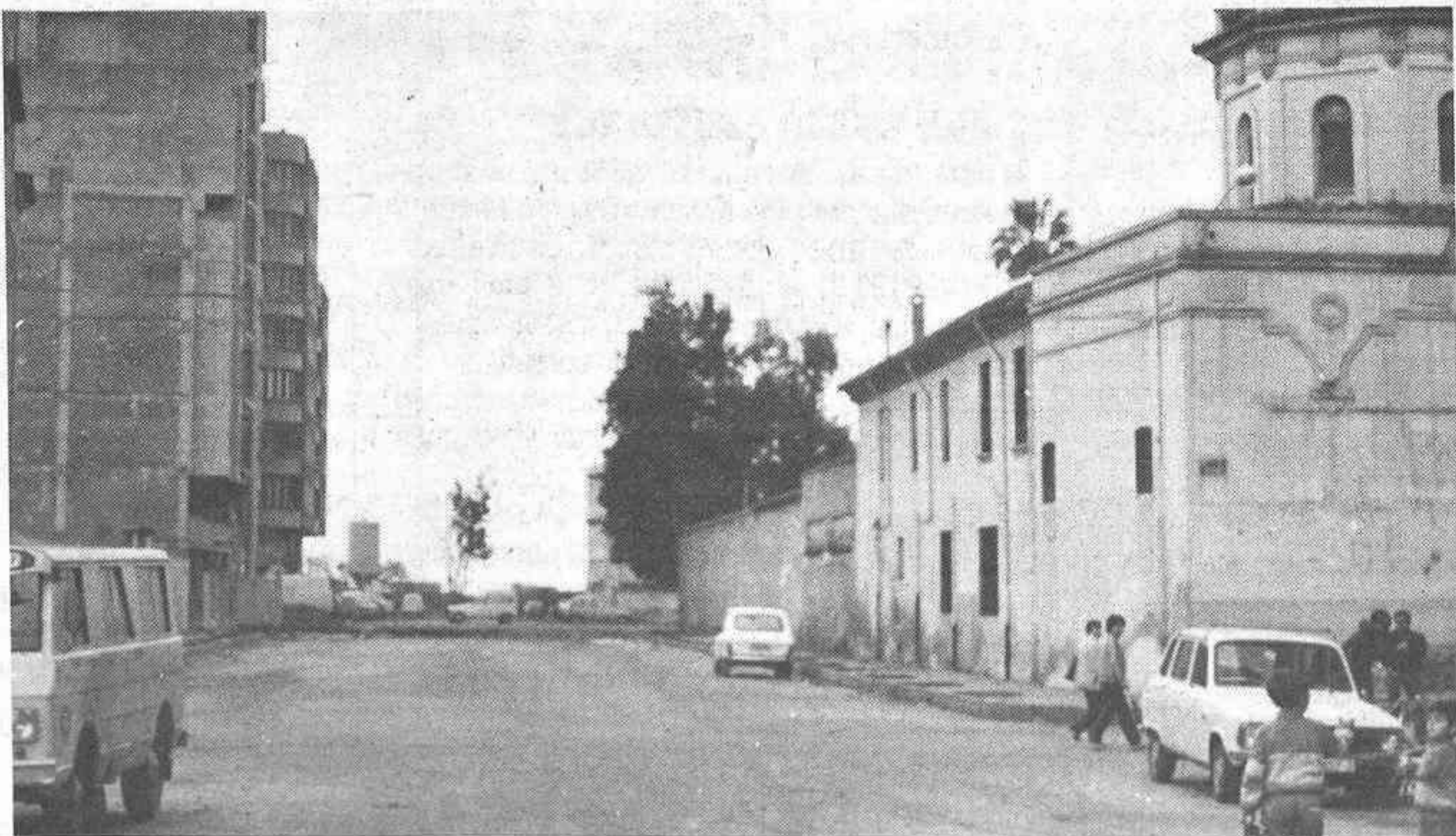
El Barranquet ha cobrado una nueva imagen a los dos meses de iniciadas las obras.
