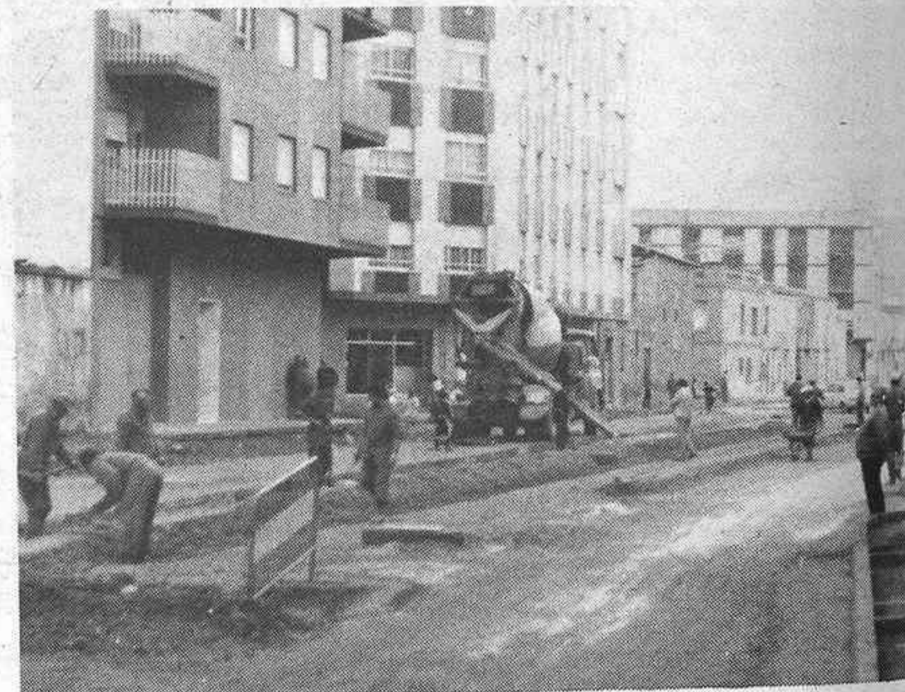
Los vecinos del Barranquet observan atentamente la evolución de los trabajos.
