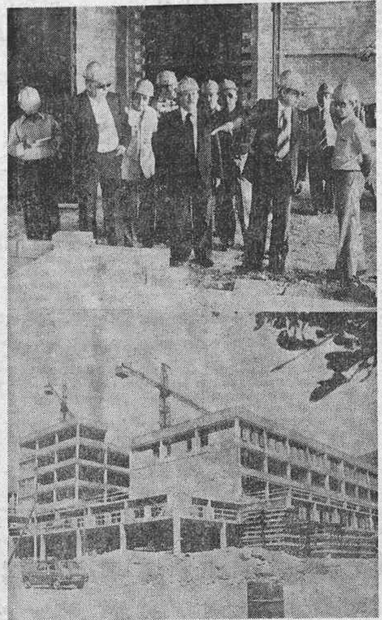
Las obras del Colegio de la Diputación están muy avanzadas
