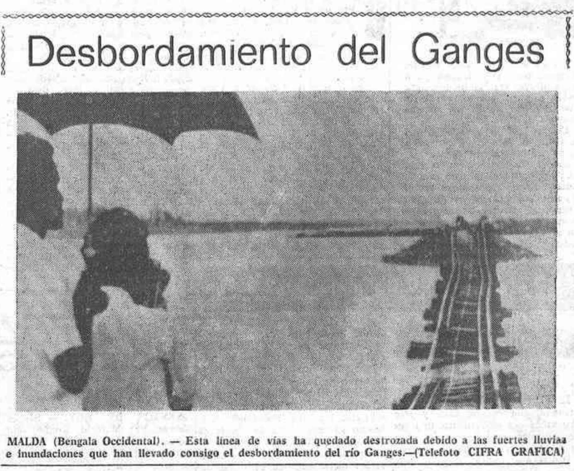
MALDA (Bengala Occidental). — Esta línea de vías ha quedado destruada debido a las fuertes lluvias e inundaciones que han llevado consigo el desbordamiento del río Ganges.—(Telefoto CIFRA GRAFICA)
