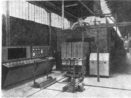
Horno túnel semi-muflado para cocción de bizcocho (azulejos de revestimiento y pavimento).
